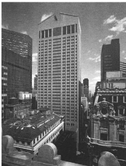
รูปที่ 2-10 อาคารเอที แอนด์ ที (AT & T Building) เมืองนิวยอร์ก ประเทศสหรัฐอเมริกา ออกแบบโดย ฟิลลิปส์จอห์นสัน (Phillips Johnson) อาคารสูงระฟ้าโพสต์โมเดิร์นหลังแรกของโลก ที่มา (สันติรักษ์ ประเสริฐสุข, 2552 : 178)
