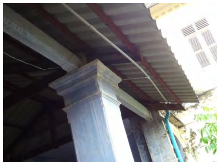
ภาพที่ 5.10 กระเบื้องลอนคู่บริเวณทางเดิน ที่มา : การสำรวจของผู้วิจัย, 9 ตุลาคม 2555
