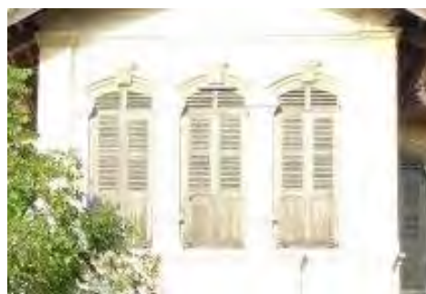
ภาพที่ 4.39 บริเวณมุขด้านหน้าอาคารชั้นบน ที่มีเสาอิงแบ่งช่วงหน้าต่างเป็น 3 ช่วง ของ
