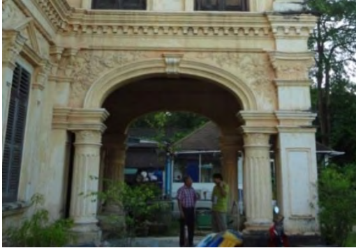
ภาพที่ 4.72 ผนังฉาบเรียบ ทาสีปูนปั้น บ้านหลวงอำนาจนราภิรักษ์ ที่มา : การสำรวจของผู้วิจัย, 9 ตุลาคม 2555
