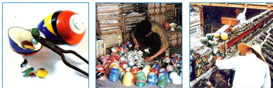
ภาพที่ 2.7 การซ่อมงานประดับกระเบื้องเคลือบด้วยการเคาะตัดขามกระเบื้อง ด้วยคีม แล้วประดับลงบนตำแหน่งเดิม
