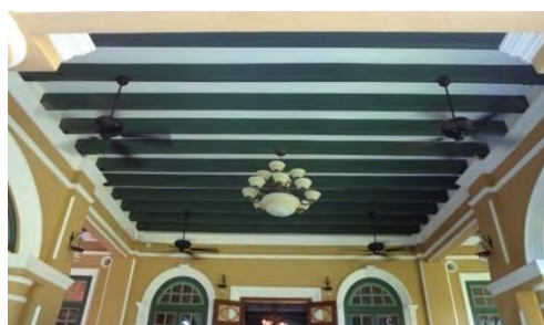
ภาพที่ 4.64 ฝ้าเพดานภายนอกบริเวณมุขใต้ถุน
