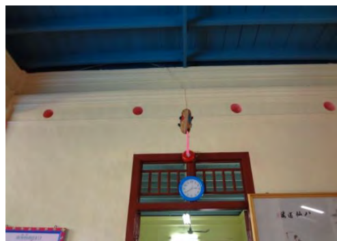
ภาพที่ 4.95 ช่องลมรูปวงกลมของ บ้านพระอร่ามสาครเขตรส่วของโรงพยาบาลศิริโรจน์ (ร้าง) และโรงเรียนอนุบาลภูเก็ตทุกฤดิดา ที่มา : การสำรวจของผู้วิจัย, 9 ตุลาคม 2555
