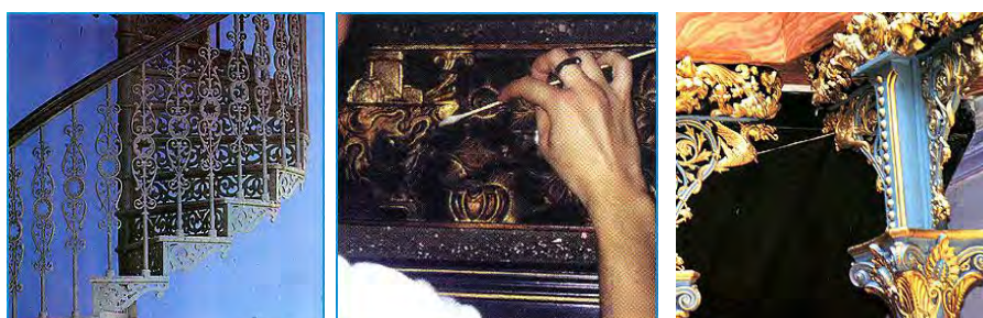
ภาพที่ 2.6 งานซ่อมแซมเหล็กและงานประดับตกแต่งด้วยทอง
