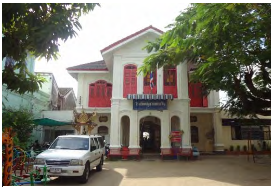
ภาพที่ 4.31 การแบ่งอาคาร 3 ช่วงเสา
