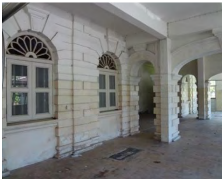
ภาพที่ 4.74 ผนังฉาบฉาบปูน เสาร่องแนวทางนอน บ้านพระอร่ามสาครเขตร โรงพยาบาลศิริโรจน์ (ร้าง), สำนักงานการบินไทย ภูเก็ต บ้านหงษ์หยก ที่มา : การสำรวจของผู้วิจัย, 19 มิถุนายน 2555
