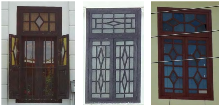
ภาพที่ 4.84 หน้าต่าง ตัวบาน 2 ช่อง บานพระอร่ามสาครเขตร ส่วนของสำนักงานการบินไทย ภูเก็ต และโรงเรียนอนุบาลภูเก็ตกุดลิดา (จากซ้ายไปขวาตามลำดับ) ที่มา : การสำรวจของผู้วิจัย, 9 ตุลาคม 2555
