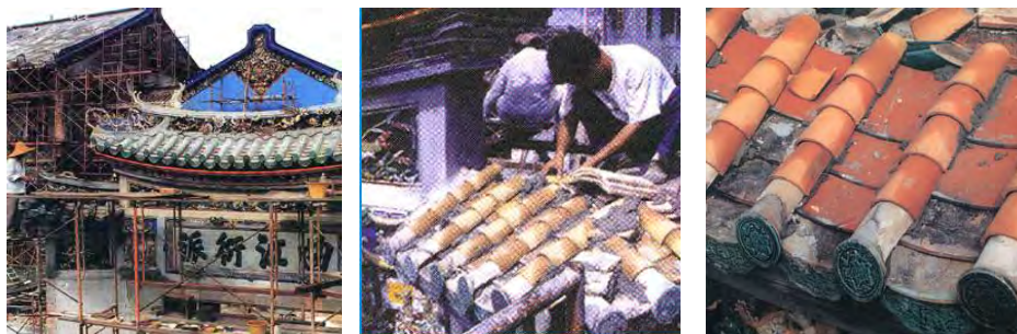
ภาพที่ 2.4 ภาพแสดงการซ่อมแซมหลังคา
