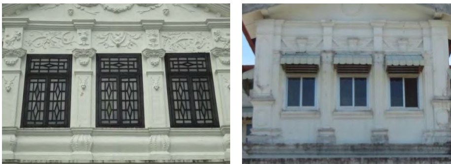
ภาพที่ 4.40 บริเวณมุขด้านหน้าอาคารชั้นบน ที่มีเสาดิ่งแบ่งช่วงหน้าต่างเป็น 3 ช่วง ของบ้านพระอร่ามสาครเขตร ส่วนสำนักงานการบินไทย ภูเก็ต (ซ้าย) และบ้านพระอร่ามสาครเขตร ส่วนโรงพยาบาลสิริโรจน์ (ร้าง) (ขวา) ที่มา : การสำรวจของผู้วิจัย, 19 มิถุนายน 2555
