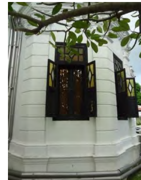
ภาพที่ 4.74 ผนังฉาบฉาบปูน เสาร่องแนวทางนอน บ้านพระอร่ามสาครเขตร โรงพยาบาลศิริโรจน์ (ร้าง), สำนักงานการบินไทย ภูเก็ต บ้านหงษ์หยก ที่มา : การสำรวจของผู้วิจัย, 19 มิถุนายน 2555
