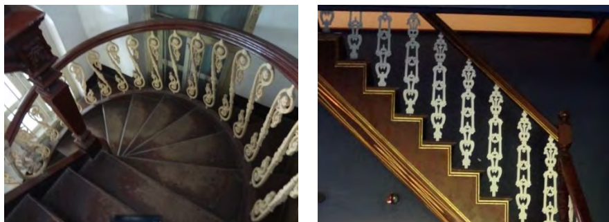
ภาพที่ 4.110 ลูกกรงหล่อด้วยเหล็ก บ้านพระอร่ามสาครเขตร่วมของโรงพยาบาลศิริโรจน์ (ร้าง) และบ้านพระพิทักษ์ชินประชา ที่มา : การสำรวจของผู้วิจัย, 9 ตุลาคม 2555
