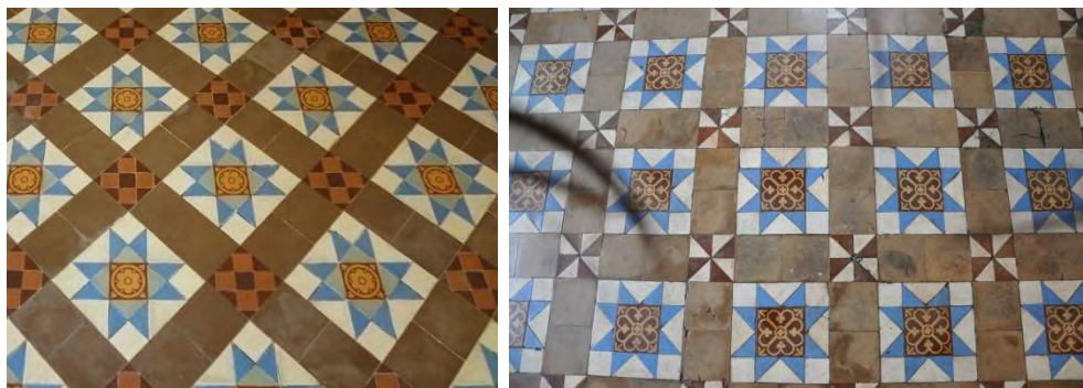
ภาพที่ 4.148 พื้นกระเบื้องดินเผาลดลายเรขาคณิต บ้านหงษ์หยก และ Chung Keng Quee Mansion, Penang ที่มา : การสำรวจของผู้วิจัย, 16 ตุลาคม 2554
