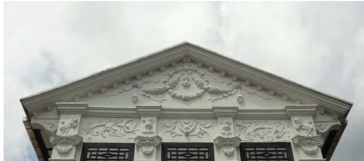
ภาพที่ 4.55 หน้าจั่วหลังคา บ้านพระอร่ามสาครเขตร สำนักงานการบินไทย ภูเก็ต ที่มา : การสำรวจของผู้วิจัย, 19 มิถุนายน 2555
