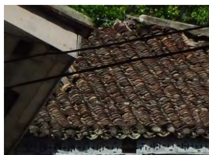
ภาพที่ 4.51 กระเบื้องดินเผาจากกล้วย
