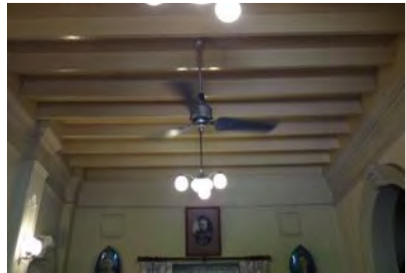
ภาพที่ 4.67 ฝ้าเพดานภายในชั้นล่าง : บ้านชินประชา ที่มา : การสำรวจของผู้วิจัย, 18 ตุลาคม 2554
