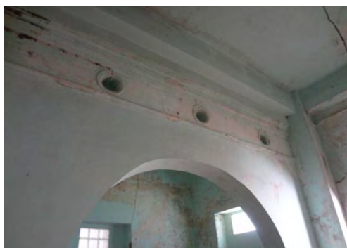
ภาพที่ 4.95 ช่องลมรูปวงกลมของ บ้านพระอร่ามสาครเขตรส่วของโรงพยาบาลศิริโรจน์ (ร้าง) และโรงเรียนอนุบาลภูเก็ตทุกฤดิดา ที่มา : การสำรวจของผู้วิจัย, 9 ตุลาคม 2555
