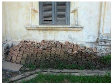
ภาพที่ 5.11 กระเบื้องกาบกล้วยที่ถดถล่มมา ขณะซ่อมหลังคา ที่มา : การสำรวจของผู้วิจัย, 9 ตุลาคม 2555
