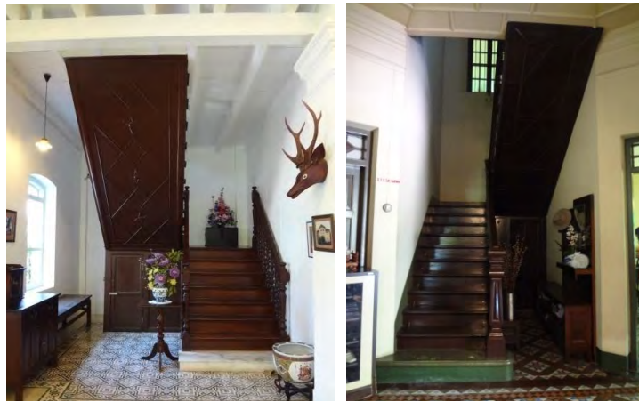
ภาพที่ 4.102 บันไดพับกลับ บ้านพระพิไสยสรรพกิจ และบ้านหงษ์หยก ที่มา : การสำรวจของผู้วิจัย, 9 ตุลาคม 2555
