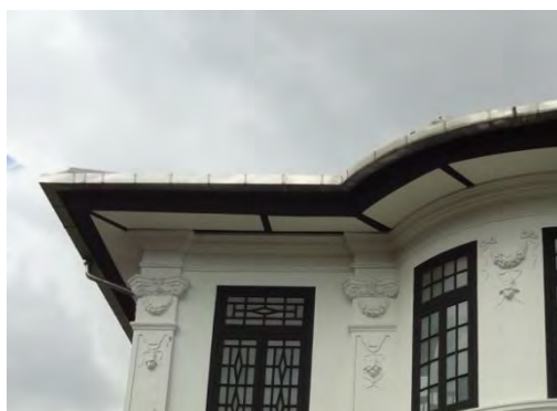
ภาพที่ 4.62 ฝ้าเพดานภายนอกตีตั้งฉาก
