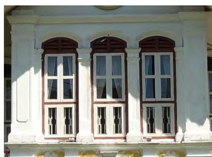
ภาพที่ 4.39 บริเวณมุขด้านหน้าอาคารชั้นบน ที่มีเสาอิงแบ่งช่วงหน้าต่างเป็น 3 ช่วง ของ
