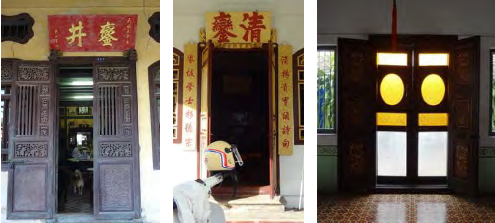
ภาพที่ 4.78 ประตูหน้าบ้านหลวงอำนาจนรารักษ์ บ้านคุณปัญญา ต่อเจริญ และบ้านชินประชา (จากซ้ายไปขวาตามลำดับ)
