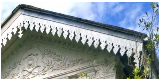
ภาพที่ 4.61 การใช้ไม้ฉลุตกแต่งชิงชายขอบหลังคา : บ้านชินประชา ที่มา : Chinese Houses of Southeast Asia, P. 141.
