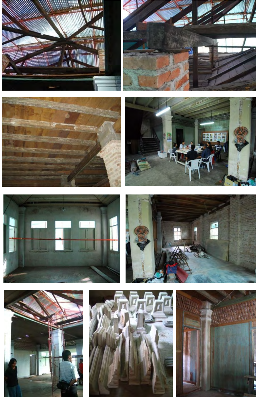
ภาพที่ 5.47 สภาพอาคารขณะทำการบูรณะ
