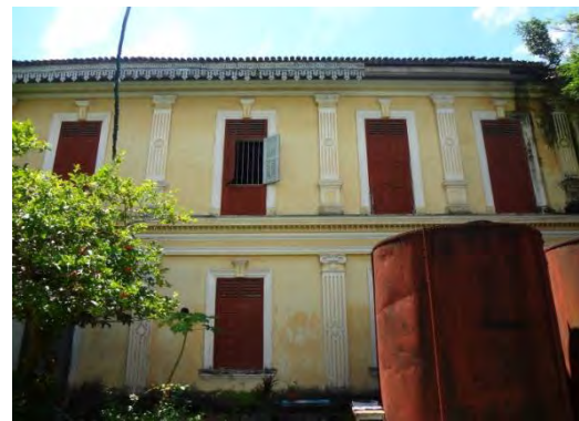
ภาพที่ 4.27 ภาพแสดงการใช้คานตกแต่งด้วยลวดบัว แบ่งอาคารชั้นบนและล่าง ของบ้านพระพิทักษ์ชินประชา (ซ้าย) และบ้านคุณเตียงก๊ก แซ่หงอ (ขวา) ที่มา : การสำรวจของผู้วิจัย, 9 ตุลาคม 2555
