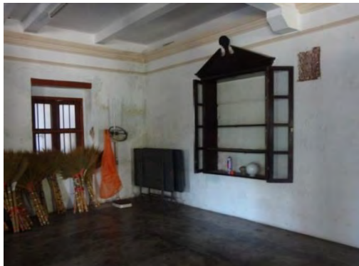
ภาพที่ 4.75 ผนังฉาบเรียบ ทาสี : บ้านคุณเฉลิม ทองตัน (ชาย) และบ้านหลวงอำนาจนวราภรณ์ (ขวา) ที่มา : การสำรวจของผู้วิจัย, 12 ตุลาคม 2555
