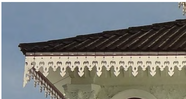
ภาพที่ 4.60 การใช้ไม้ฉลุตกแต่งชิงชายขอบหลังคา บ้านคุณบัญญัติ ต่อเจริญ ที่มา : การสำรวจของผู้วิจัย, 12 ตุลาคม 2555
