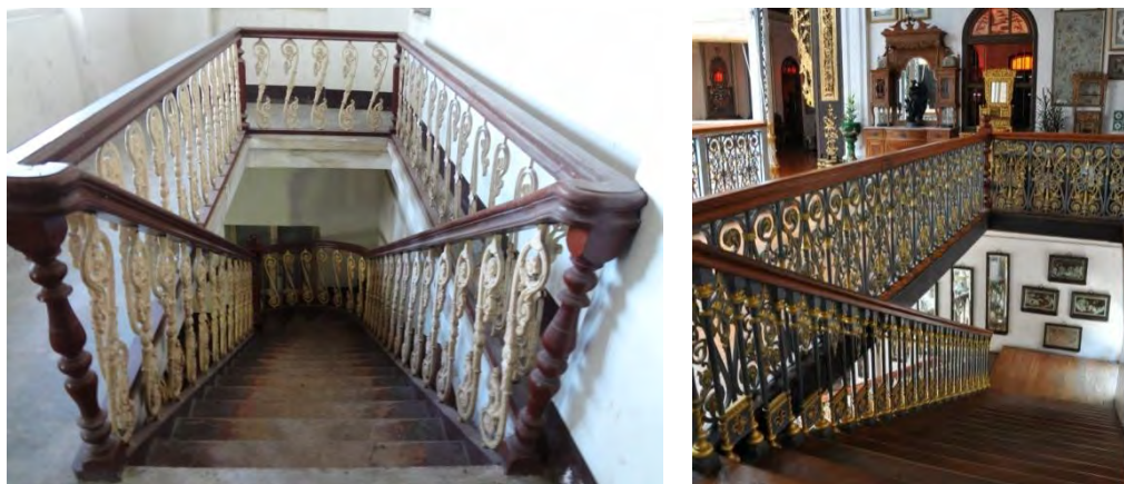
ภาพที่ 4.149 ลูกกรงบันไดหล่อเหล็ก บ้านพระอร่ามสาครเขตรและ Chung Keng Quee Mansion, Penang
