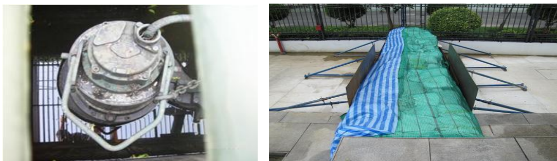
รูปที่ 3.70 จุดที่ 2 สถานีสูบน้ำหลักด้านการทางพิเศษ
