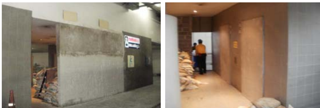
รูปที่ 3.10 จุดที่ 6 ทางเข้าอาคารบริเวณลิฟต์โดยสาร
