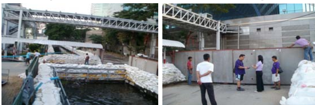
รูปที่ 3.6 จุดที่ 2 ทางเข้าออกอาคารประตู 6
