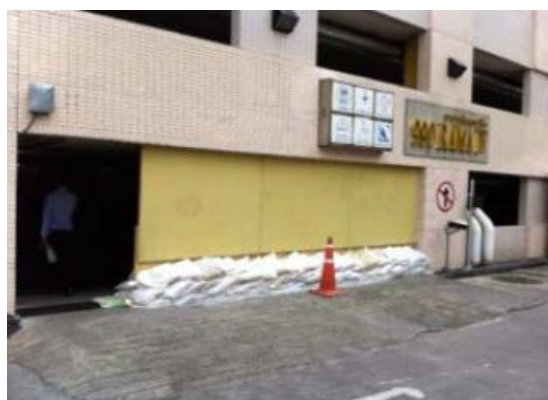
รูปที่ 3.48 จุดที่ 7 ประตูทางออกด้านหลังอาคาร
