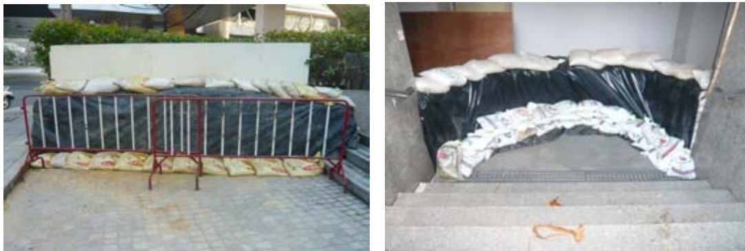
รูปที่ 3.55 จุดที่ 3 จุดบันไดทางลงST.17 ด้านบนและด้านล่าง
