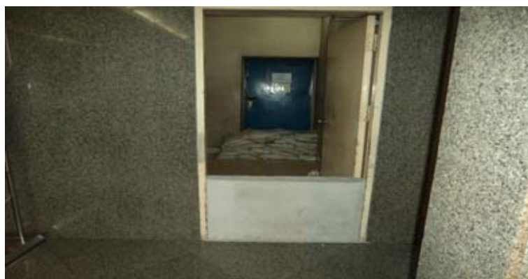
รูปที่ 3.30 จุดที่ 3 บริเวณบันไดหนีไฟ
