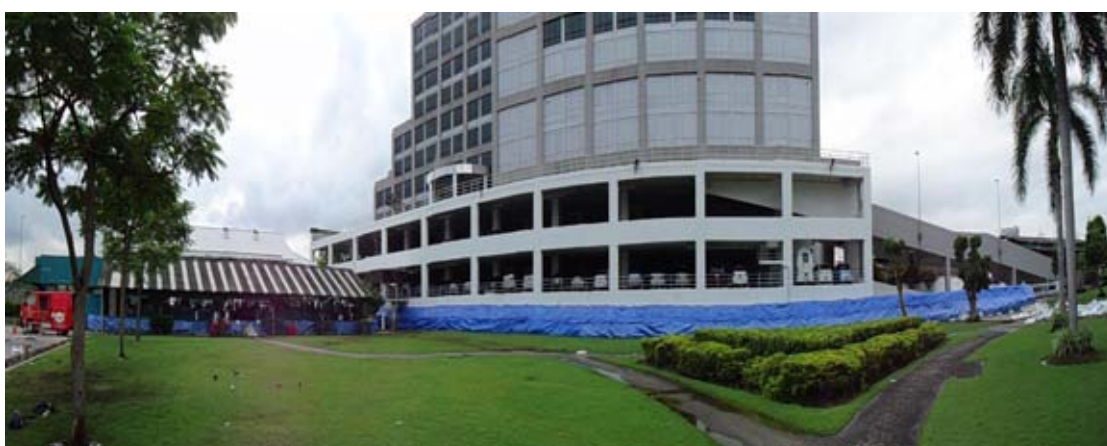
รูปที่ 3.59 อาคารธนาคารกรุงเทพ(พระราม3)
