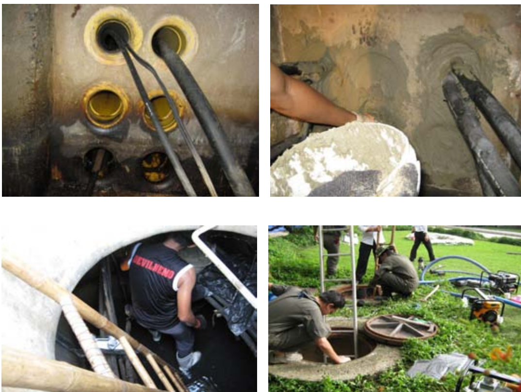
รูปที่ 3.62 ปิดช่องท่อสายสัญญาณเข้าภายในอาคาร
