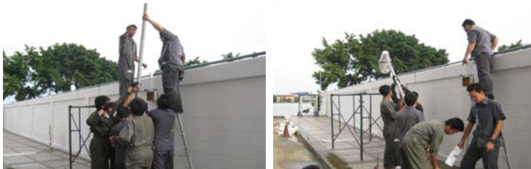
รูปที่ 3.60 งานติดตั้งแสงสว่างเพิ่มเติม
