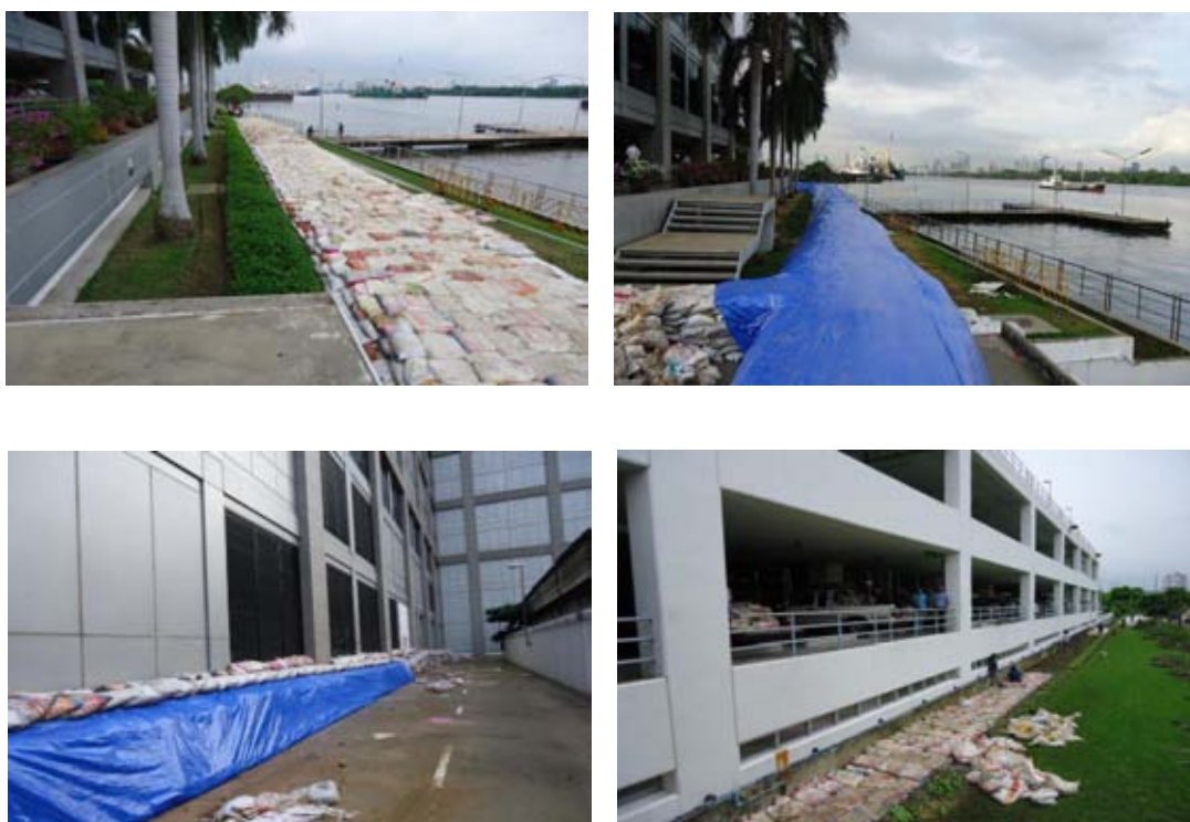
รูปที่ 3.61 แนวกันรอบอาคาร ใช้กระสอบทรายคลุมด้วยแผ่นพลาสติก
