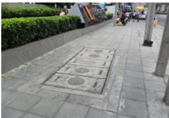
รูปที่ 3.54 จุดที่ 2 จุดแผ่นคอนกรีตปิดกล่องโทรศัพท์
