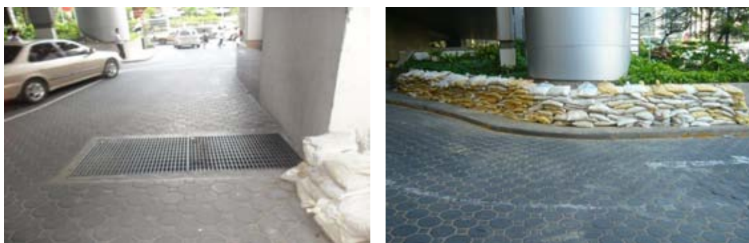
รูปที่ 3.57 จุดทางเข้าออกอาคาร บริเวณช่องระบายอากาศ
