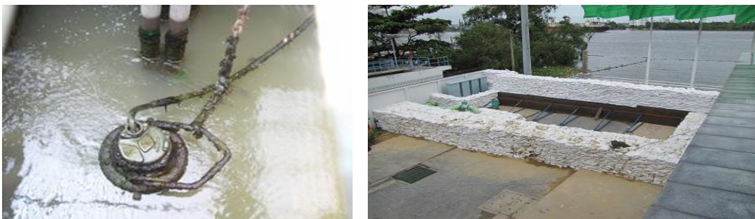
รูปที่ 3.69 จุดที่ 1 สถานีสูบน้ำหลักด้านการไฟฟ้า
