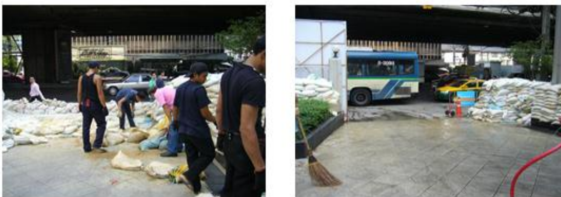
รูปที่ 3.40 การเรือแนวกันกระสอบทราย
