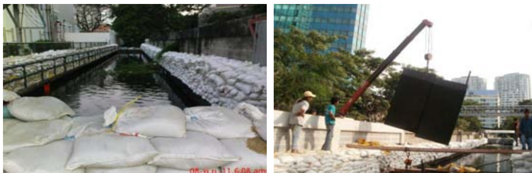
รูปที่ 3.8 จุดที่ 4 แนวลำรางสาธารณะ
