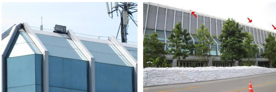
รูปที่ 3.68 ตำแหน่งเพิ่มแสงสว่างภายนอกอาคาร
