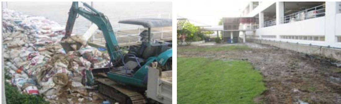
รูปที่ 3.65 การรื้อถอนแนวกันกระสอบทราย
