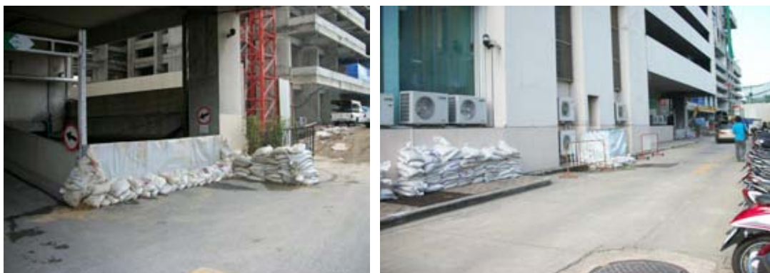
รูปที่ 3.23 ด้านข้างอาคารทิศเหนือ บริเวณทางลงชั้นใต้ดิน
