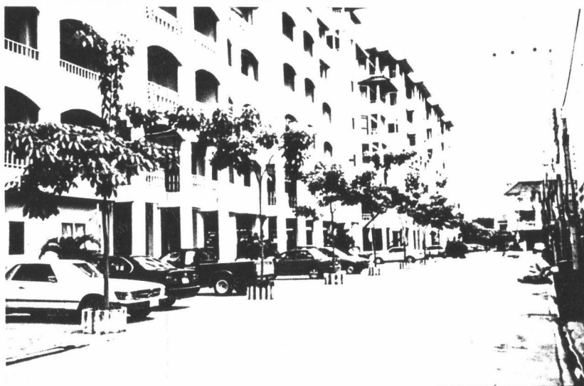
รูปที่ 3-20 บริเวณที่จอดรถด้านข้างและใต้อาคารโครงการ ศรีวรการร์เดิน คอนโดมิเนียม
