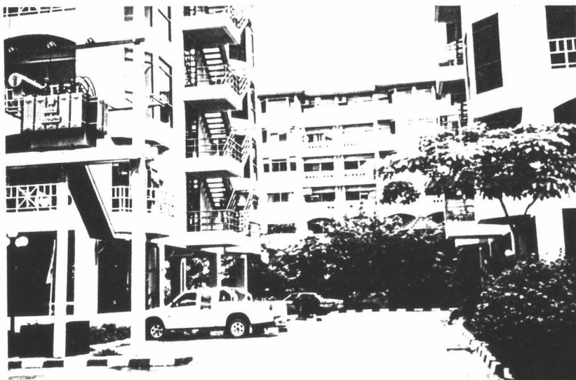
รูปที่ 3-19 สภาพอาคารทั่วไปในโครงการ ศรีวรการร์เดิน คอนโดมิเนียม
