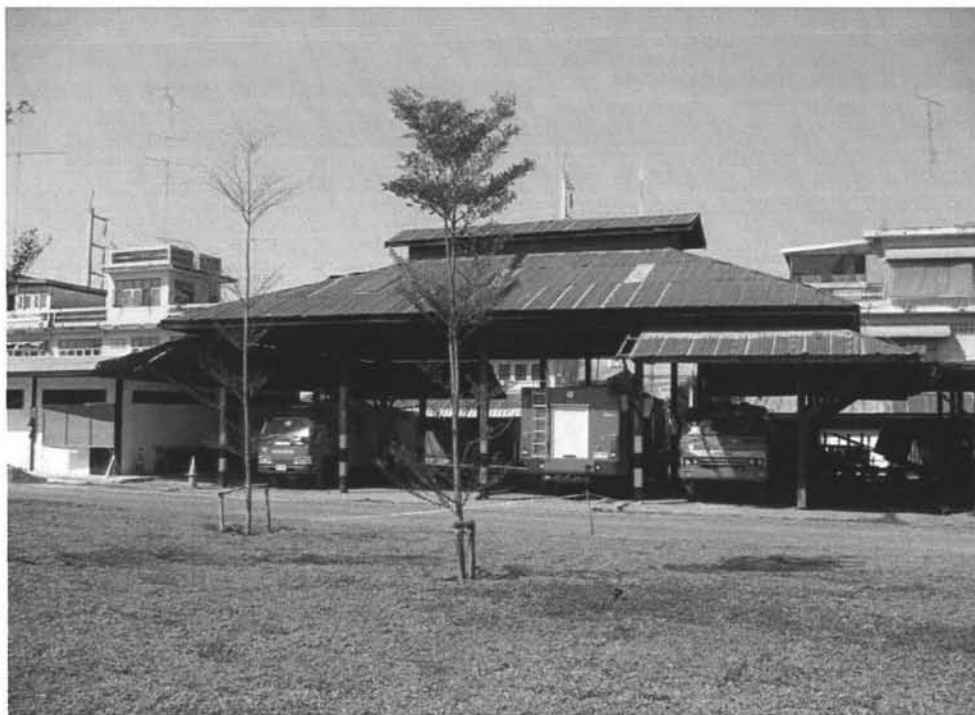
โรงจอดรถดับเพลิงภายในที่ตั้งสำนักงานเทศบาลตำบลกึ่งแอน
