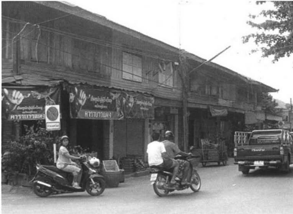
ย่านชุมชนการค้าเก่าบริเวณหน้าสถานีรถไฟปากช่อง
