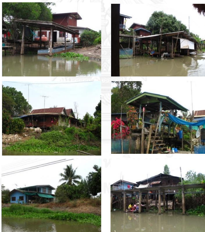
ภาพที่ 4. 15 : (ซ้าย-ขวาบน) ที่อยู่อาศัยริมน้ำคลองขวางหมู่ 14 พร้อมศาลาเก็บเรือประจำบ้าน (ซ้าย-ขวากลาง) บ้านเดี่ยวใต้ถุนสูง ชุมชนสวนมะม่วงหมู่ 11 และศาลา ริมน้ำ
