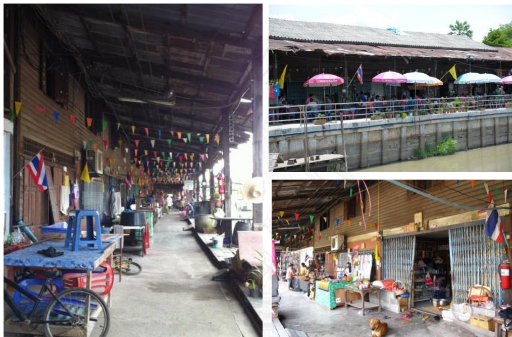
ภาพที่ 4. 20 : ห้องแถวร้านค้าริมน้ำ คลองนครเนื่องเขต ผังชุมชนสวนมะม่วง หมู่ที่ 10 (ตระกูลตันสงวนวงศ์)
