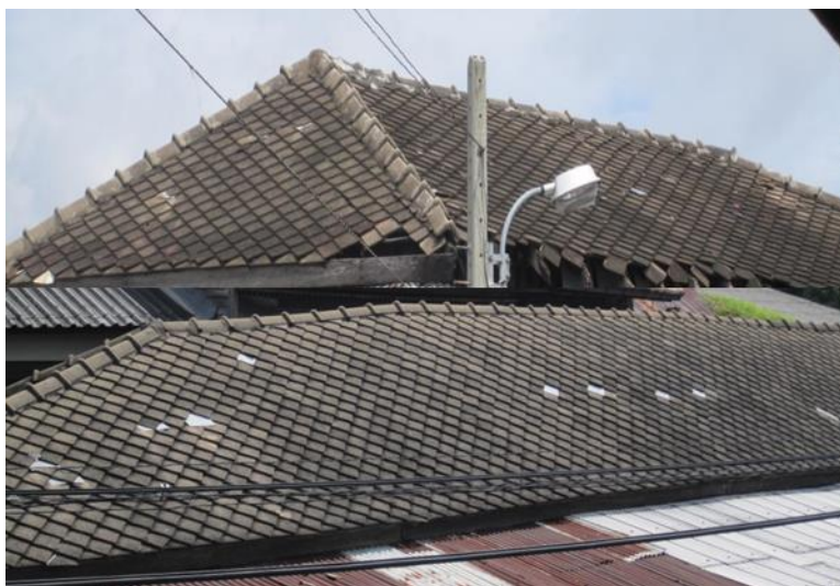
ภาพที่ 31 หลังคากระเบื้องว่าวที่มีลักษณะเหมือนลายข้าวหลามตัด
