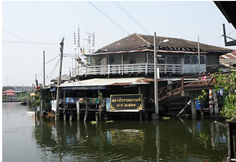
ภาพที่ 29 อาคารทรงปั้นหยา มุงหลังคาด้วยกระเบื้องว่าว ตั้งอยู่หัวมุมชุมชนตลาดเก่า
