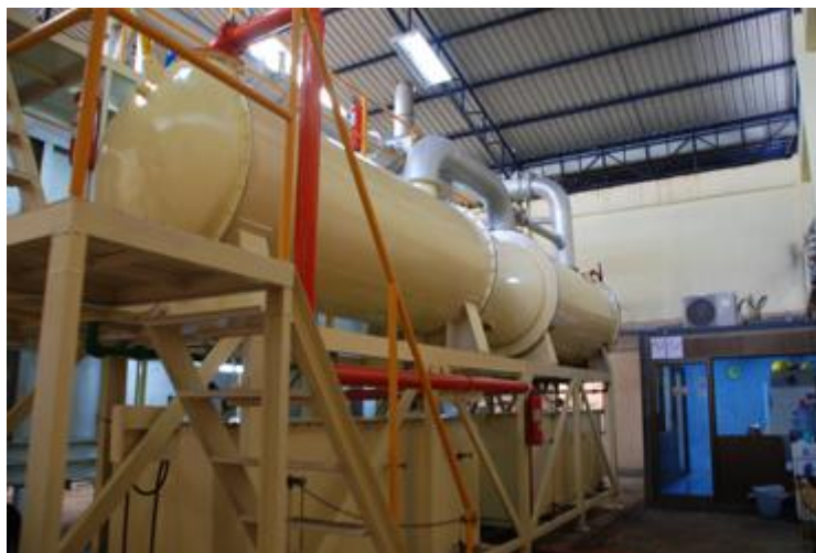
รูปที่ 2.33 เครื่องควบแน่น บจก. เทอร์มเอ็นจิเนียริง
