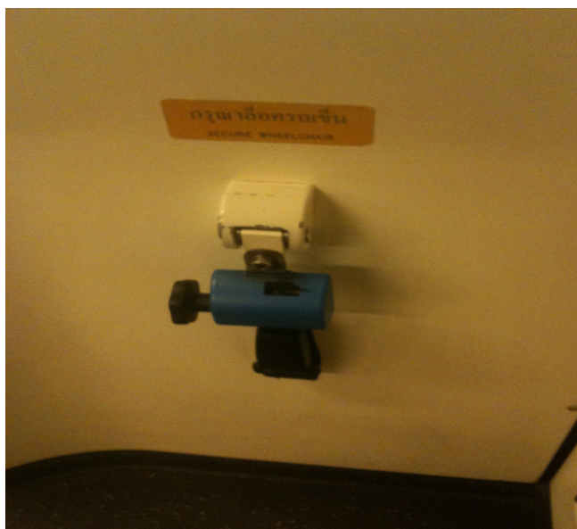
ภาพที่ 22 ที่ล็อครถวีลแชร์สำหรับคนพิการทางการเคลื่อนไหว
