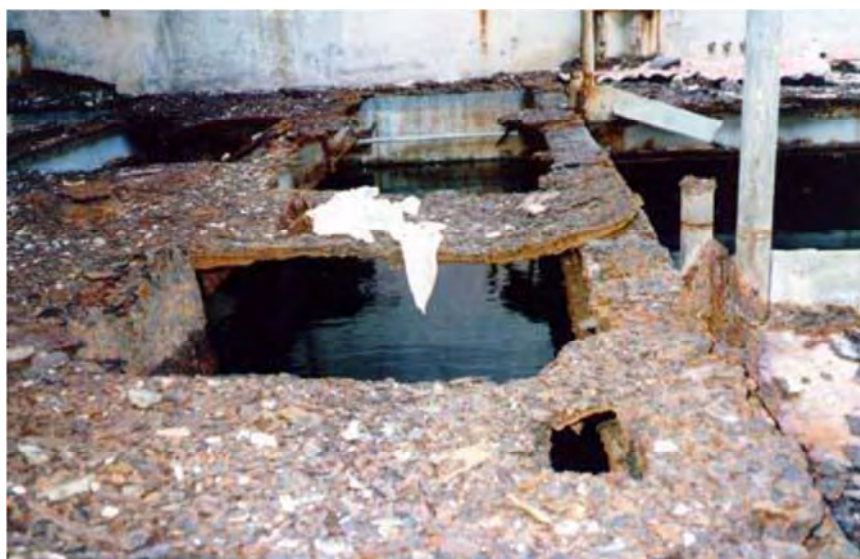
รูปที่ 2.7 โลหะที่ถูกกัดกร่อนจนเสื่อมสภาพ
