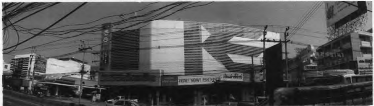
รูปที่ 4.7 การใช้ประโยชน์ที่อาคารประเภทพาณิชยกรรมบริเวณย่านการค้าใหม่ริมถนนสุขุมวิท ของเมืองชลบุรี (ที่มา: จากการสำรวจพื้นที่, 2550)
