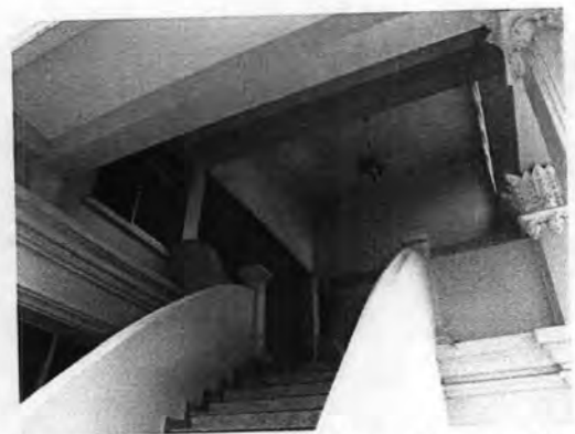
ภาพที่ 3.3-25 ลักษณะของโคมไฟแบบช่อห้อยบริเวณโถงบันไดทางขึ้นชั้น 2
