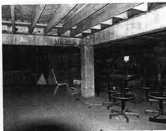
ภาพที่ 3.4-20 ลักษณะโครงสร้างพื้นไม้ บริเวณใต้เวที
