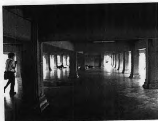
ภาพที่ 3.2-18 ลักษณะแนว ตาราง คานคอนกรีตเสริมเหล็กและเสาบริเวณชั้นใต้ถุนอาคาร
