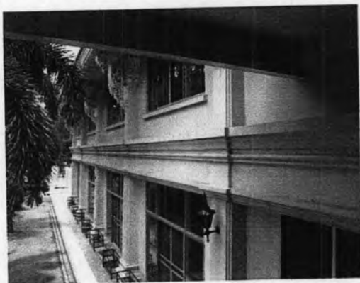
ภาพที่ 3.3-17 รูปแบบของบัวคอนกรีตเสริมเหล็ก ถอดพิมพ์ที่ครอบอาคาร
