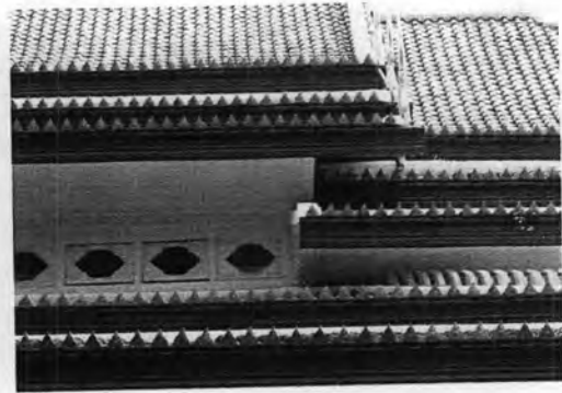
ภาพที่ 3.1-6 ลักษณะของแผงคอสองและลักษณะการซ้อนทับของหลังคา
