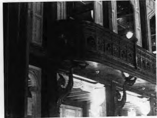
ภาพที่ 3.2-20 ลักษณะโครงสร้างพื้นชั้นที่ 2 บริเวณส่วนพื้นยื่นชั้นลอย
