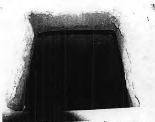
ภาพที่ 3.1-29 ช่องเปิด สำหรับบ่อที่เก็บน้ำใต้ดิน บริเวณใต้ถุนอาคาร
