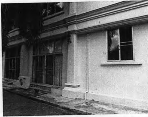
ภาพที่ 3.3-13 ลักษณะการเจาะช่องเปิดผนังอาคาร
