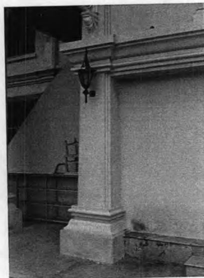
ภาพที่ 3.3-18 ลักษณะของเสาภายนอกอาคาร
