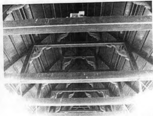
ภาพที่ 3.2.17 ภาพรวมของโครงสร้างหลังคาหลัก แสดงถึงระบบ โครงสร้าง
