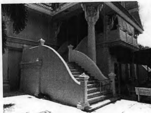
ภาพที่ 3.3-15 ลักษณะของบันไดทางขึ้นอาคาร
