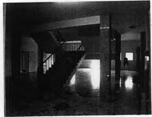
ภาพที่ 3.3-4 บริเวณพื้นที่โถงบันไดภายในอาคาร
