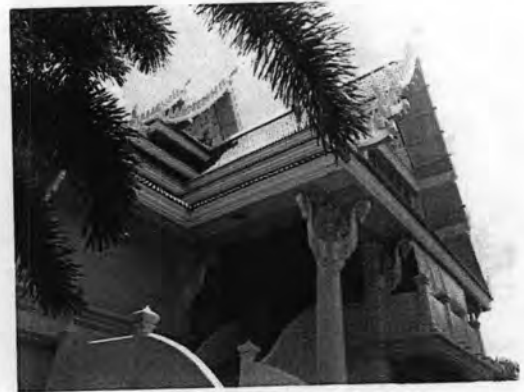
ภาพที่ 3.3-10 ลักษณะการซ้อนชั้นหลังคา บริเวณมุขด้านหน้า
