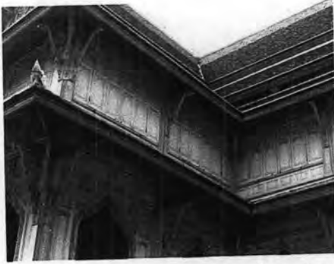
ภาพที่ 3.2-12 ความสัมพันธ์ของผนังและค้ำยันหลังคา
