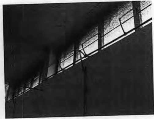
ภาพที่ 3.3-23 ลักษณะของการให้แสงทางช่องเกล็ดกระจกในแผงคอสองภายในอาคาร
