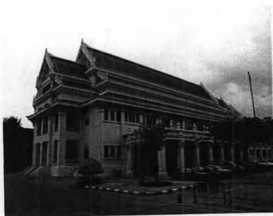
ภาพที่ 3.4-12 ลักษณะโดยรวมด้านหลังอาคาร
