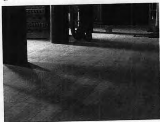
ภาพที่ 3.1-22 ลักษณะของพื้นคอนกรีตเสริมเหล็ก แสดงถึงลักษณะการวางไม้พื้น
