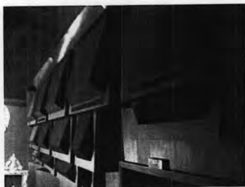
ภาพที่ 3.5.20 ลักษณะของช่องปล่อยลมเย็นภายในห้องประชุม
