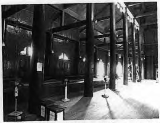
ภาพที่ 3.1-15 รูปแบบโครงสร้างภายในโถงกลางศาลาการ เปรียญ แสดงถึงระบบโครงสร้างช่วงผนังด้านและหลังคาชั้นลด
