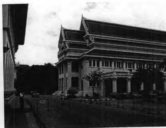
ภาพที่ 3.4-11 มุมมองหลังอาคาร ทิศตะวันออก
