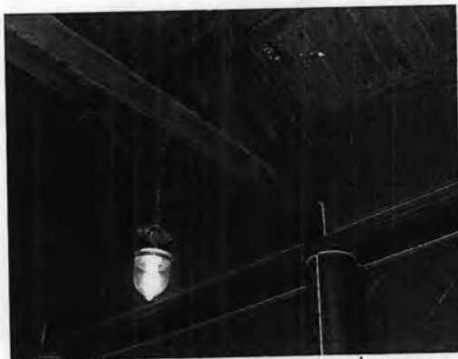
ภาพที่ 3.1-27 รูปแบบของโคมไฟแบบดวงเดี่ยวภายในอาคาร
