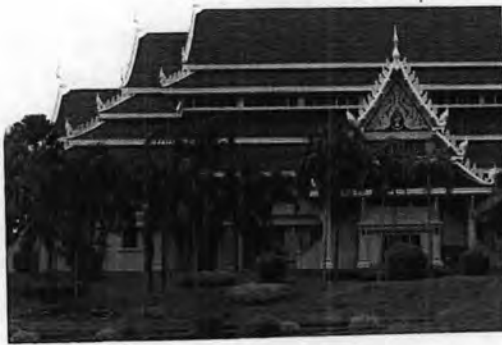
ภาพที่ 3.3-9 ลักษณะการซ้อนชั้นหลังคา บริเวณมุขด้านหลัง
