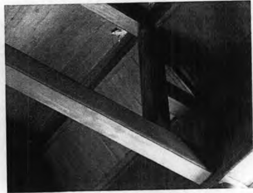
ภาพที่ 3.1-19 ลักษณะโครงสร้างหลังคา ในชั้นหลังคาหลัก ดับที่ 5 แสดงถึงตำแหน่งชื่อประธาน และการตั้งเสาตึกตาขึ้นไปรับชื่อโทในหลังคาดับที่ 4
