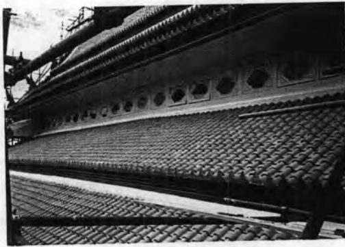
ภาพที่ 3.1-5 การให้แสงของแผงคอสองเข้าสู่ตัวอาคาร
