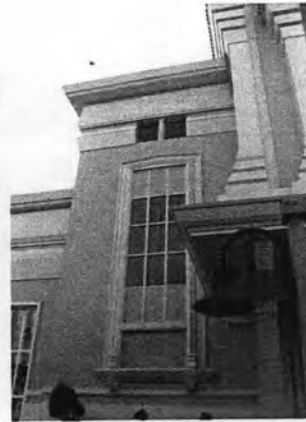
ภาพที่ 3.5.17 รูปแบบหน้าต่าง บริเวณอาคารมุขด้านหน้า
