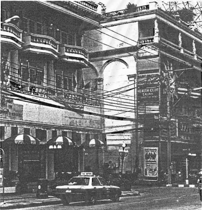
ภาพที่ 1.27: ตึกแถวทั่วไปซึ่งปลูกสร้างขนานไปกับแนวถนน มีระเบียง หรือกันสาดขนาดเล็ก ใช้เป็นที่วางเครื่องแอร์ และป้ายโฆษณา [ตึกแถวริมถนนอุดมสุข]
