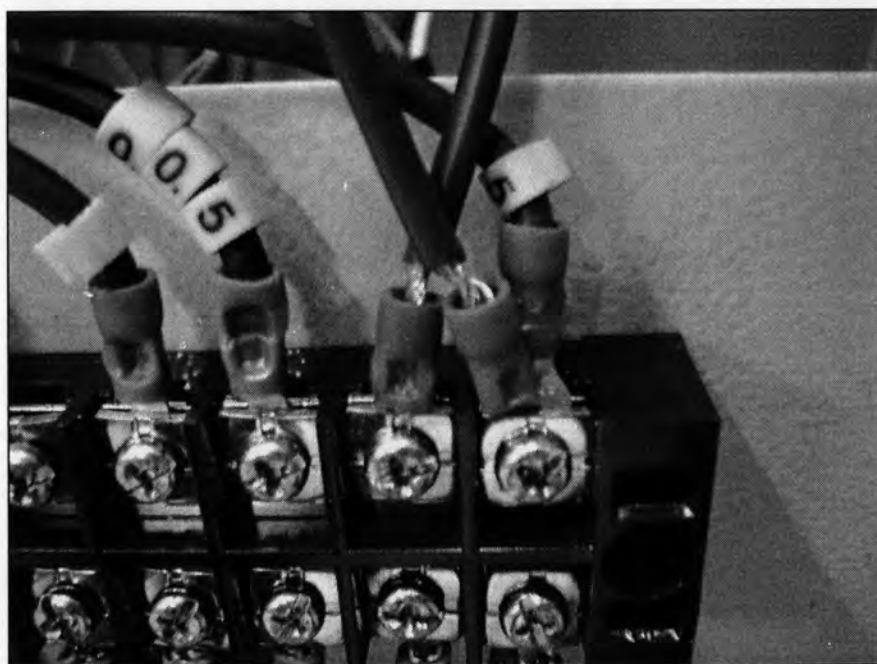
รูปที่ 4.10 แสดงภาพสายไฟที่อาจทำให้เกิดการลัดวงจร
