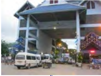
สะพานข้ามแม่น้ำสาย : หน้า 83
