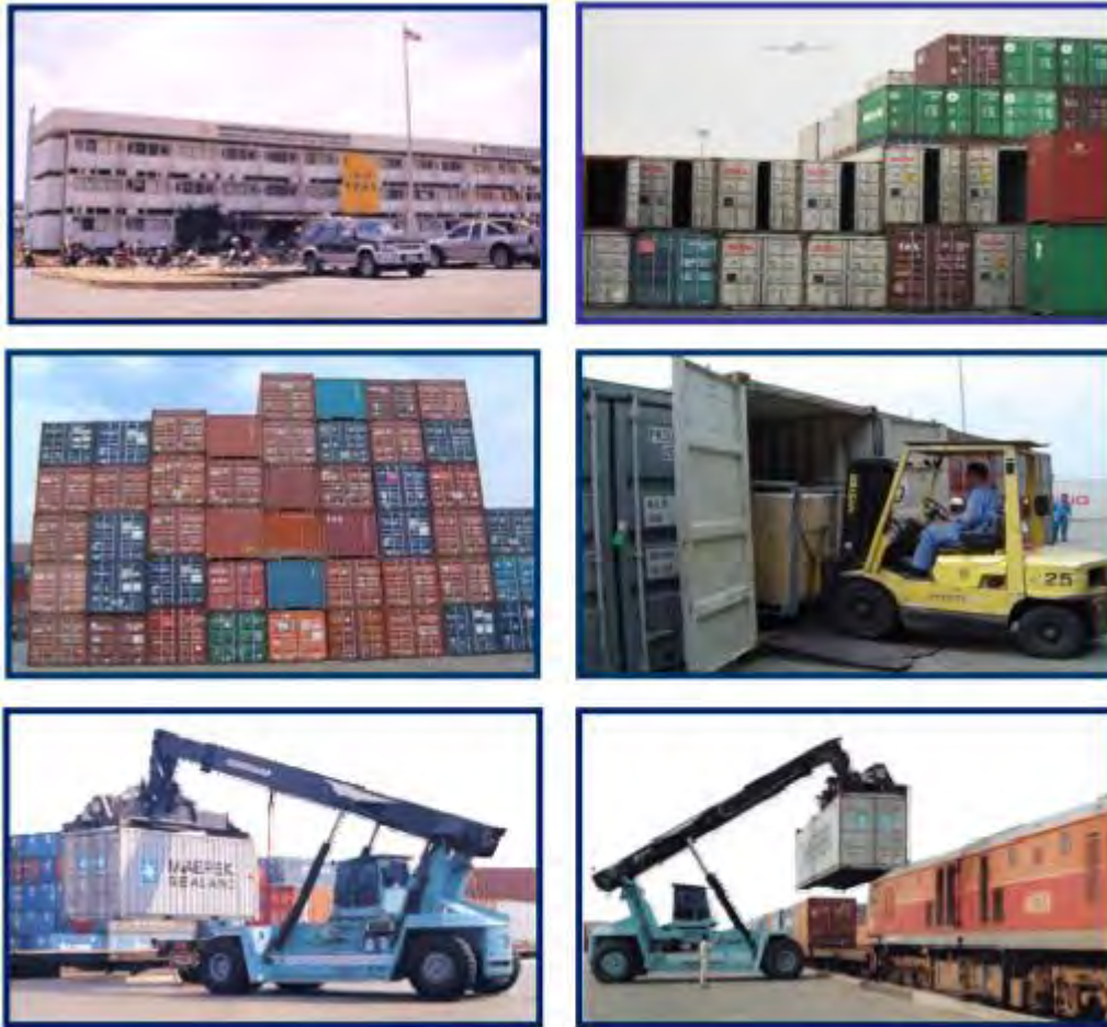
รูปที่ 14 ลานกองเก็บตู้สินค้า และยกตู้สินค้าจากแคร่บรรทุก
