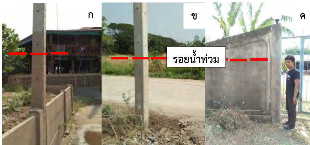
รูปที่ 3.3 รูปแสดงตัวอย่างร่องรอยน้ำท่วมในพื้นที่ ในแต่ละบริเวณ คือ (ก) เสาไฟฟ้าในชุมชน, (ข) เสาไฟฟ้าบริเวณที่โล่งนอกเขตชุมชนเมือง, (ค) กำแพงในเขตบ้านเรือน
