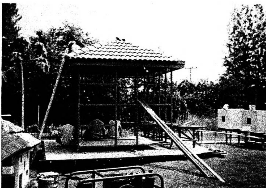
ภาพที่ 3.15 แสดงการมุงหลังคาอาคารบ้านทดลอง
