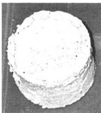
ภาพที่ 2.4 ลักษณะการเสื่อมสภาพของปูนก่อและปูนฉาบจากสารละลายเกลือ
