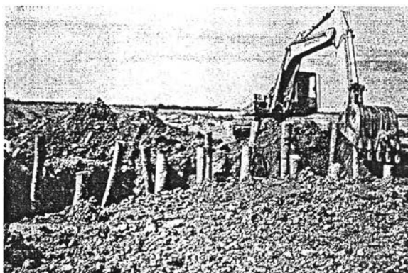
รูปที่ 3.11 ขั้นตอนการตอกเข็มไม้
