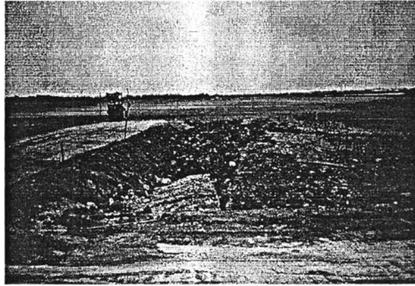
รูปที่ 3.15 การถมก้นดินชั้นที่ 2
