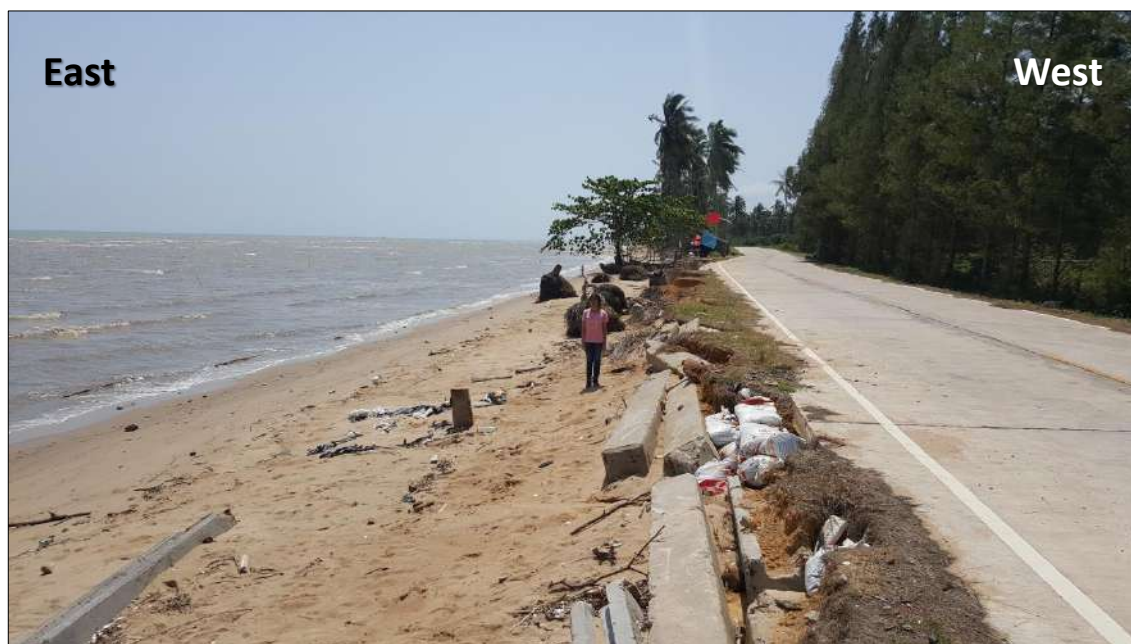
รูปที่ 5.8 ชายฝั่งที่ถูกกักเซาะถึงถนนเลียบชายฝั่งหาดสำเร็จ บริเวณระหว่างเส้น Transect ที่ 3 – 4
