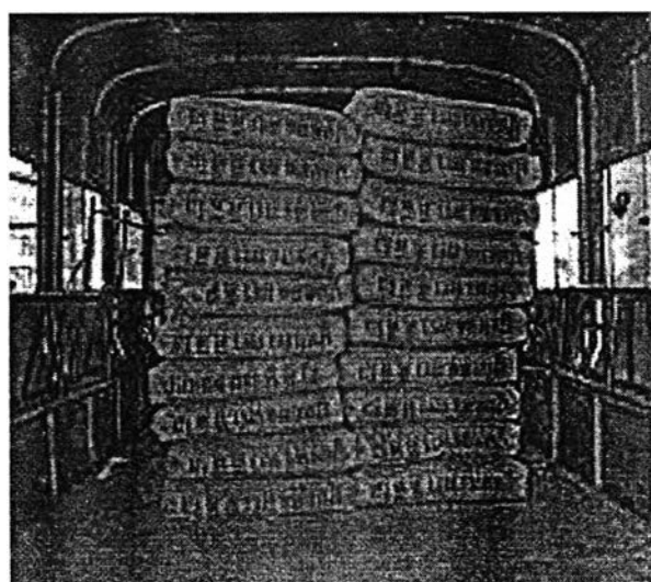
รูปที่ 4.7 การเรียงถุงปูนให้เป็นกองรวมกันในกระบะบรรทุก
