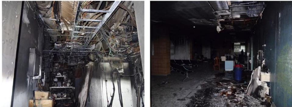
รูป 5.3 สภาพความเสียหายจากการลุกไหม้และความร้อน
