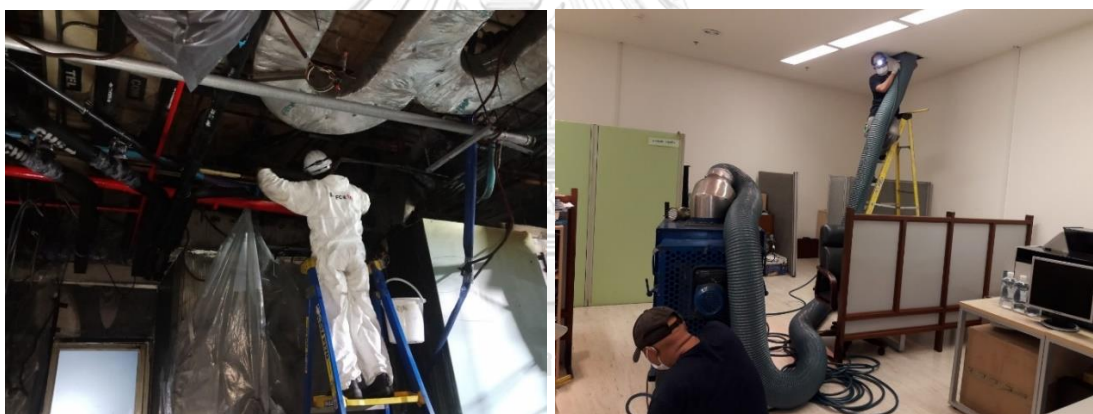
รูป 8.6 การดำเนินงานขจัดสิ่งปนเปื้อนพื้นที่เหนือฝ้าเพดานและงานระบบ
