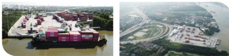
ภาพที่ 21 ท่าเรือบาร์จ ขนาดกว้างหน้าท่า 96 เมตร สามารถจอดเรือพร้อมกันได้ 2 ลำ
