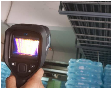
รูปที่ 4-25 การใช้ thermoscan วัดอุณหภูมิของสายไฟก่อนเข้าตู้ MDB ถ่ายเมื่อ ; 12 กันยายน 2562
