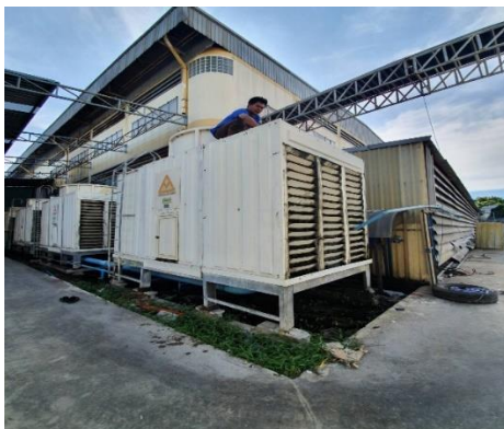
รูปที่ 4-19 แสดงการกำจัดตะกรันออกจากแผงกระจายน้ำ
