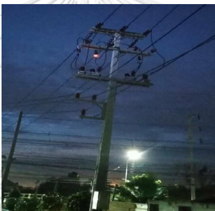
รูปที่ 4-23 แสดงฟิวส์ของระบบไฟฟ้าเกิดการอาร์ค ถ่ายเมื่อ ; 14 มกราคม 2562
