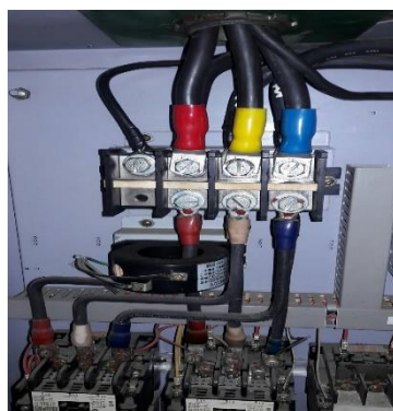
รูปที่ 4-21 แสดงการเปลี่ยนสายไฟ Main ใหม่
