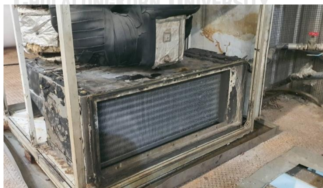
รูปที่ 4-35 แสดงคอยล์เย็นของ Mold dehumidifier
