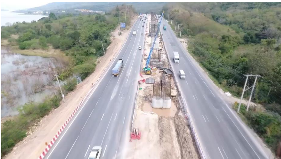
รูปที่ 1.2 ภาพจากการใช้กล้องติดตั้งอากาศยานไร้คนขับในการสำรวจโครงการ
