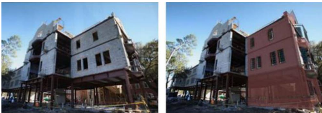
รูปที่ 1.4 การใช้เทคโนโลยี Augmented Reality เพื่อระบุพื้นที่ในการเพิ่มโครงสร้างเหล็กในงานก่อสร้าง (Shanbari et al., 2016)
