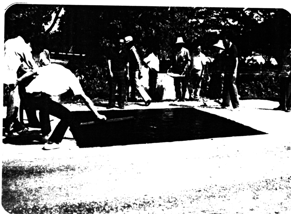
รูปที่ 4.7 ทำการปาดยางที่ลาดให้เรียบด้วยไม้ปาด
