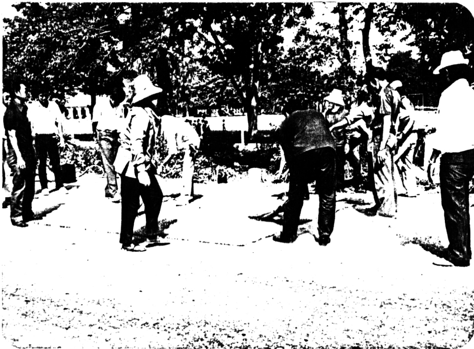
รูปที่ 4.10 ทำการกวาดเกลี่ยเม็ดดินเผาหลังการบดอัดครั้งแรก เพื่อเติมส่วนที่เกิด ช่องว่างในแปลงทดลอง
