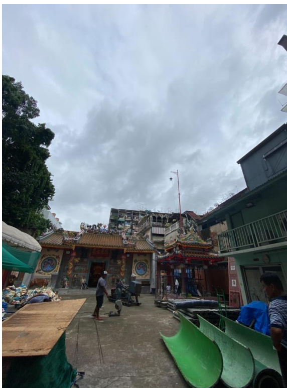
ภาพที่ 13 ศาลเจ้าเล่งบ้วยเอี้ยะขณะได้รับการบูรณะใหม่ วันที่ 9 ตุลาคม พ.ศ. 2563
