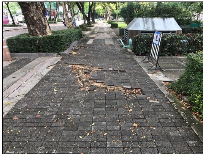
ภาพที่ 3-4 ความเสียหายของพื้นผิวทางเท้า
