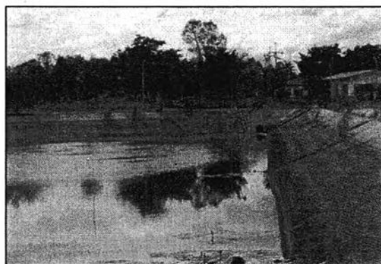
รูปที่ 4-138 ระบบบำบัดน้ำเสียชุมชน เทศบาลตำบลบางระกำ จ.พิษณุโลก
