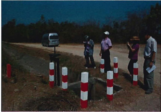
คลองส่งน้ำจากอ่างเก็บน้ำห้วยตะแปด
