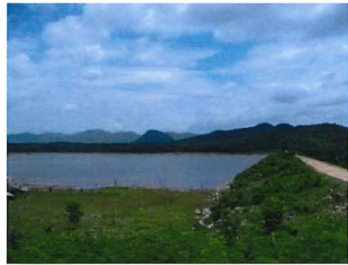
อ่างเก็บน้ำห้วยทราย
