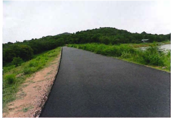
ถนนบนสันอ่างเก็บน้ำเขากระปุก
