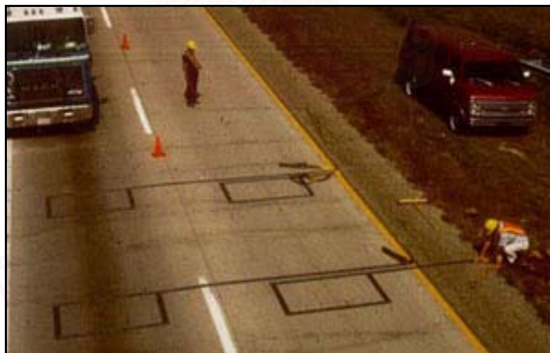
รูปที่ 1.1 Inductive Loop [3]
