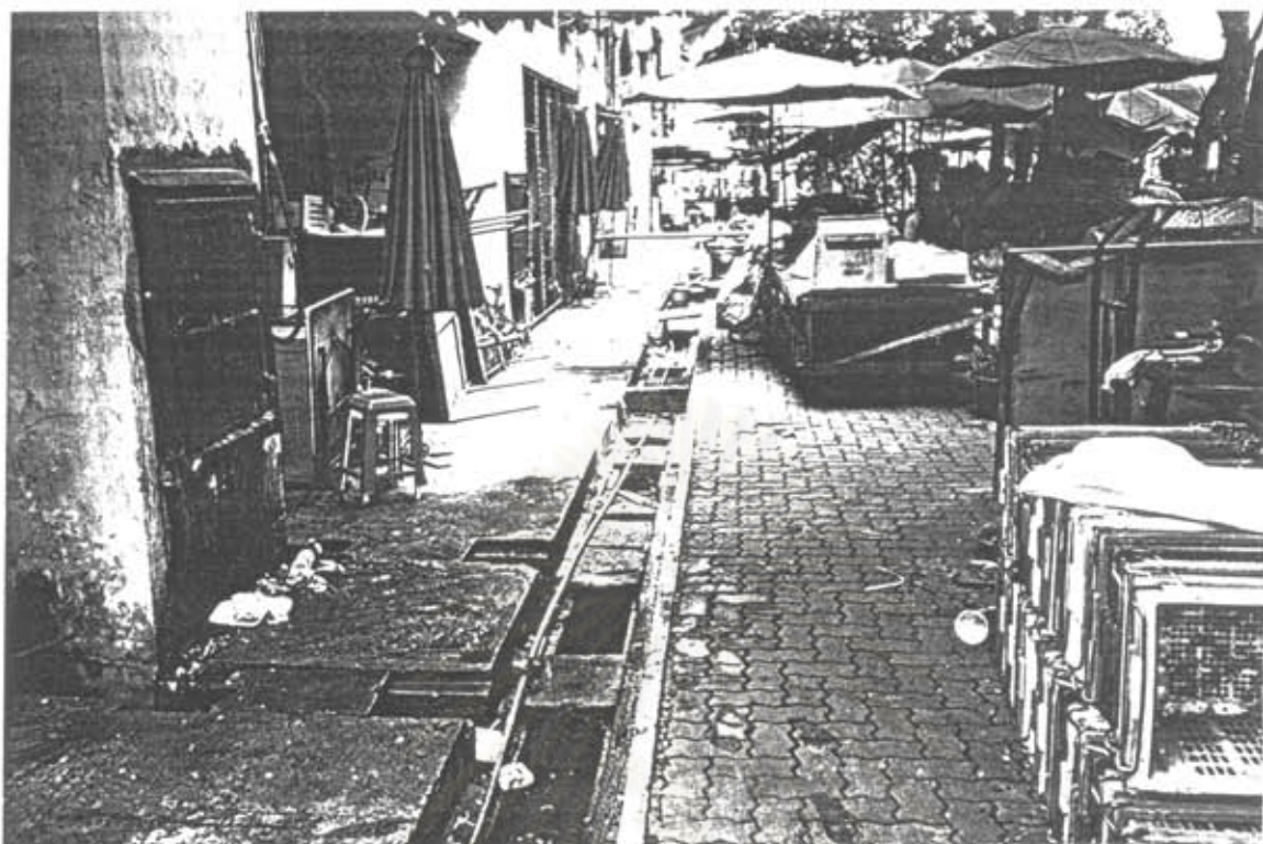
ภาพที่ 5-21 ทางระบายน้ำชั้นล่าง ด้านหลังอาคาร
