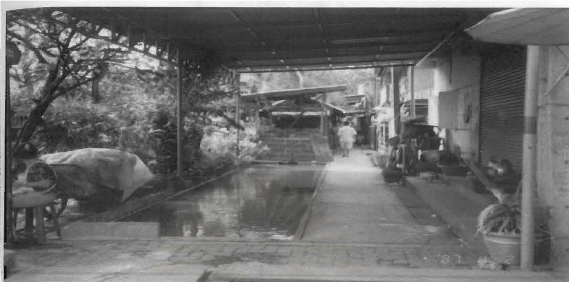
ภาพที่ 7 ระบายน้ำภายในชุมชน
