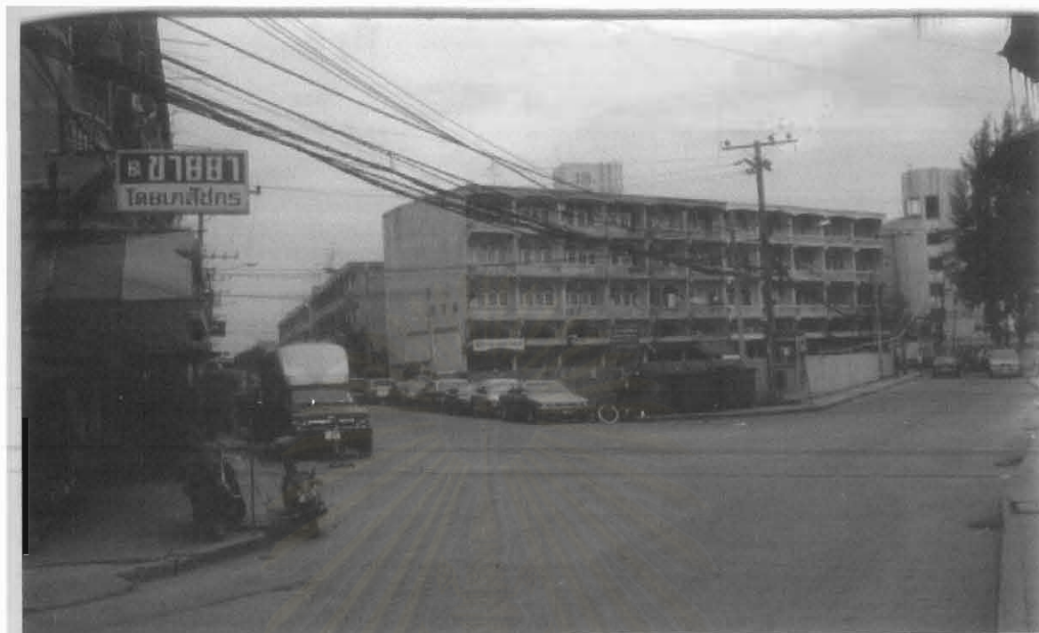
ภาพที่ 3 ถนนสายหลักกว้าง 12 เมตร (ผ่านแปลงที่ดินแปลง ช.) เชื่อมต่อกับถนนที่ผ่านแปลงของการเคหะแห่งชาติทางทิศตะวันตกของโครงการทางเข้า-ออกชุมชนหมู่บ้านพัฒนา 70 ไร่
