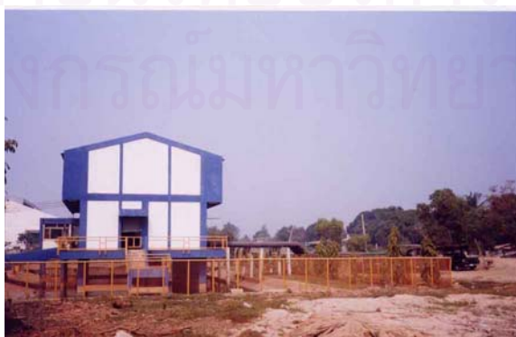
รูปที่ 3-14 รูปถ่ายโรงสูบน้ำในพื้นที่เขตนิคมอุตสาหกรรม
