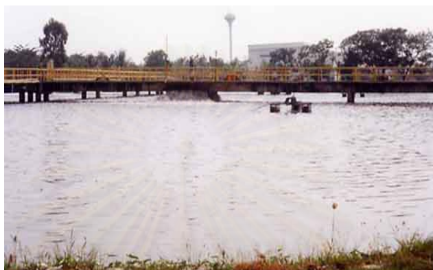
รูปที่ 3-13 รูปถ่ายบ่อบำบัดน้ำเสียในพื้นที่เขตนิคมอุตสาหกรรม
