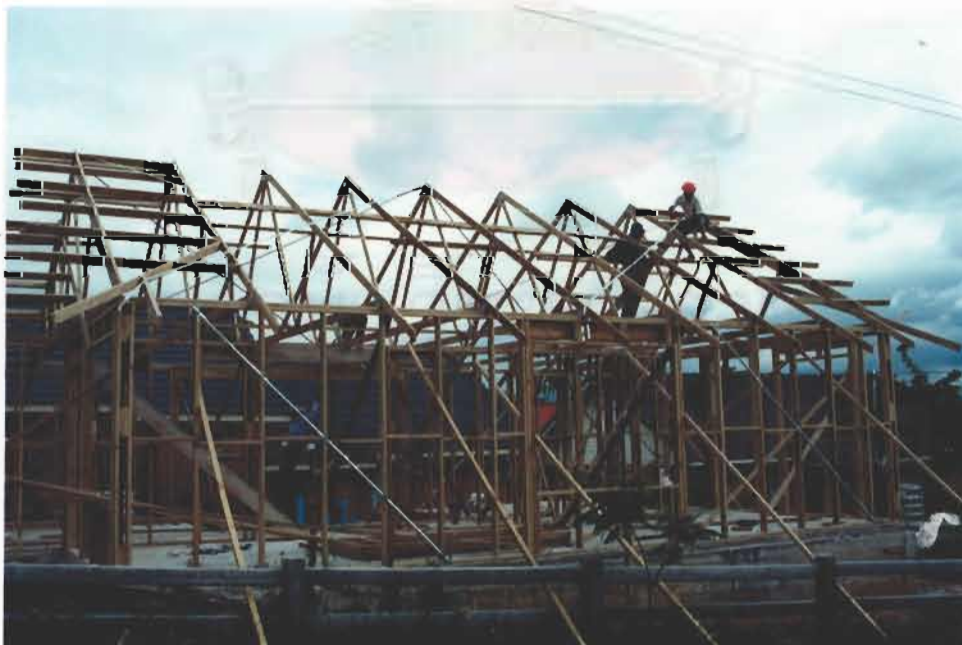
รูปที่ 4-36 การติดตั้งยึดแนวทแยง
