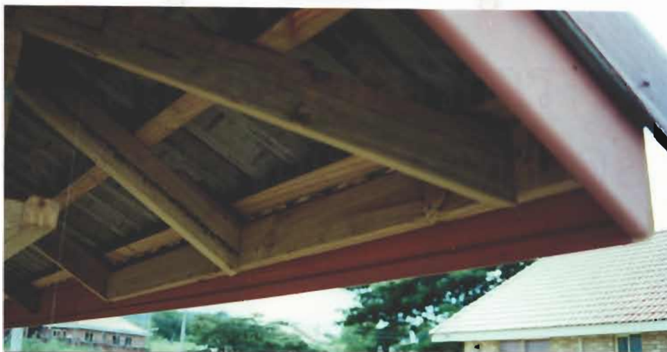
รูปที่ 4-44 โครงฝ้าเพดานภายนอกโดยจะสอดแผ่นกระเบื้องในร่องไม้ปิดชายคา
