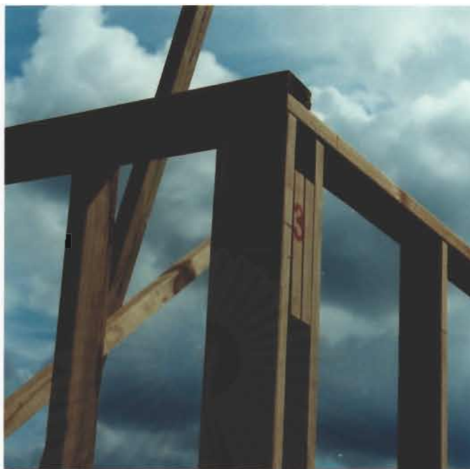
รูปที่ 4-23 มุมของโครงไม้แต่ละโครงจะมีหมายเลขตรงกันเพื่อให้ง่ายต่อการทำการติดตั้ง
