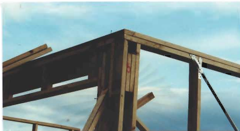
รูปที่ 4-29 ลักษณะการติไม้ทับหลังบริเวณมุมอาคาร
