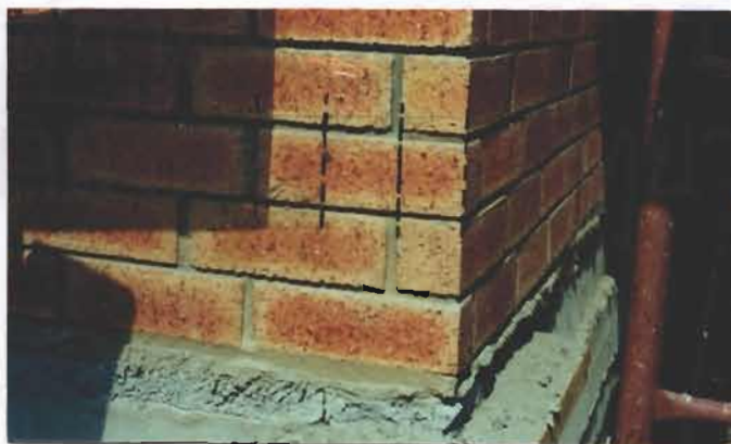
ลักษณะการก่ออิฐด้วยการขีดระหว่างก้อนแบบ 1/3 ก้อน (Bonding)
