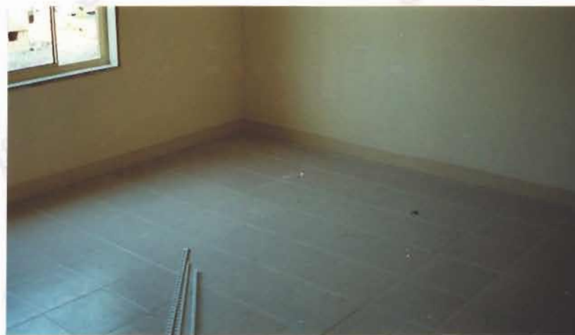
รูปที่ 4-53 การติดตั้งวัสดุปูพื้น
