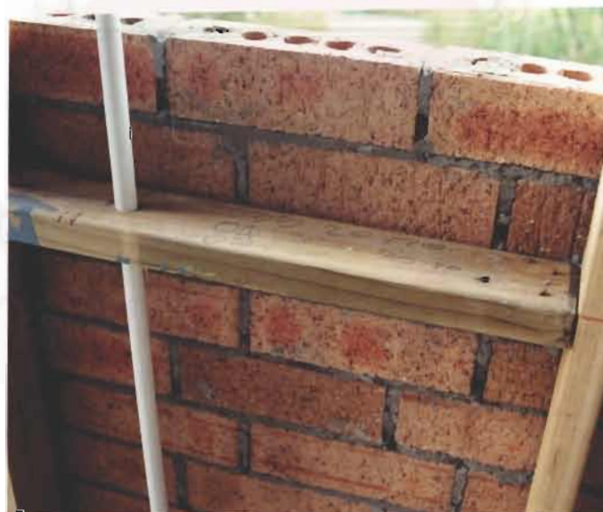
รูปที่ 4-40 การร้อยท่อทะลุผ่านโครงเคร่าแนวนอน
