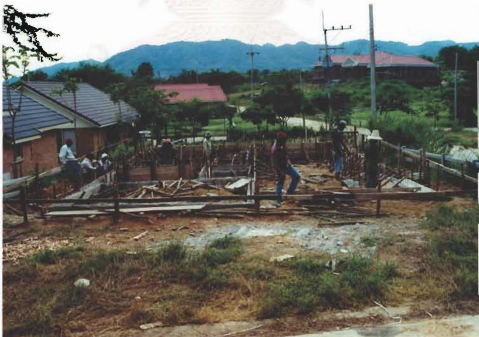
รูปที่ 4-15 วิธีการทำผนังฐานรากโดยการตั้งแบบเพื่อเทคอนกรีตครั้งที่สอง
