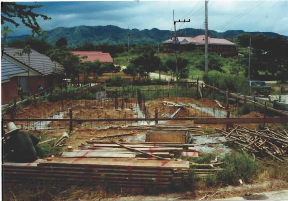
รูปที่ 4-14 การทำฐานรากในส่วนฐานและการเสียบเหล็กเพื่อรอทำผนังฐานราก
