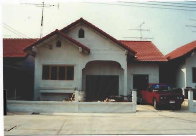
รูปที่ 4-66 การติดตั้งบ้านประตุน้ำต่างอาคารพักอาศัยระบบทั่วไป งานวงกบประตูและหน้าต่างไม้เนื้อแข็งประกอบในที่ กรอบบานไม้สักยกเว้นประตูทางเข้าหลักเป็น วงกบอะลูมิเนียมลูกฟักกระจกใส
