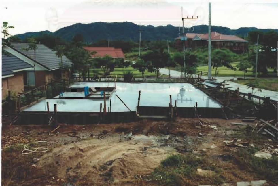
รูปที่ 4-18 พื้นสำเร็จรูปที่ใช้ในโครงการ
