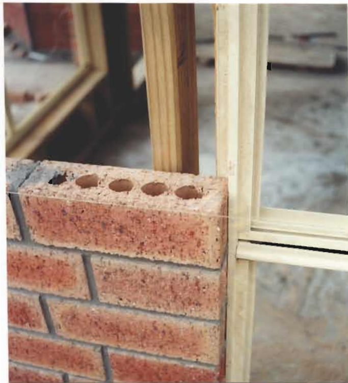
รูปที่ 4-50 การก่ออิฐชนกับวงกบหน้าต่างทางด้านข้าง
