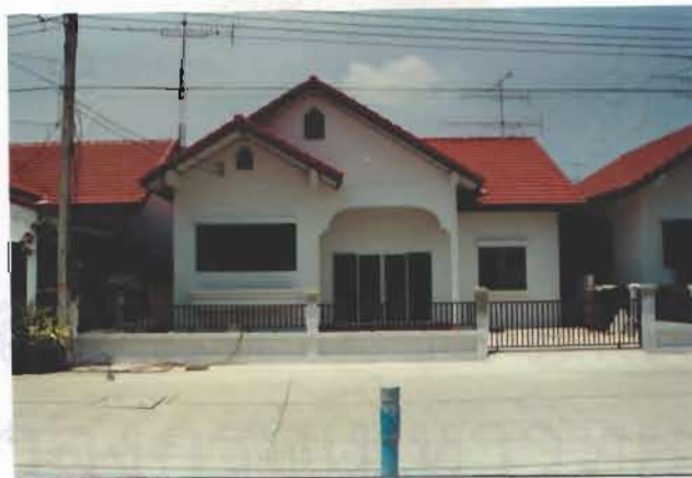
รูปที่ 4-67 บ้านระบบก่อสร้างทั่วไปที่ก่อสร้างเสร็จสมบูรณ์ งานทาสีอาคารใช้สีพลาสติกทั้งภายในและภายนอกอาคาร
