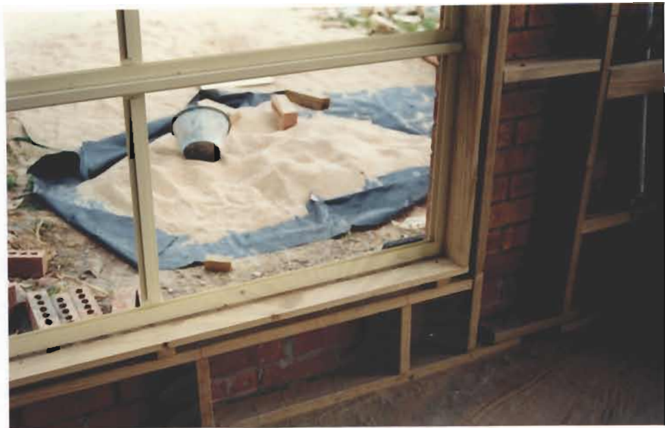
รูปที่ 4-43 การติดตั้งวงกบโดยมีไม้ปรับระดับทางด้านล่าง
