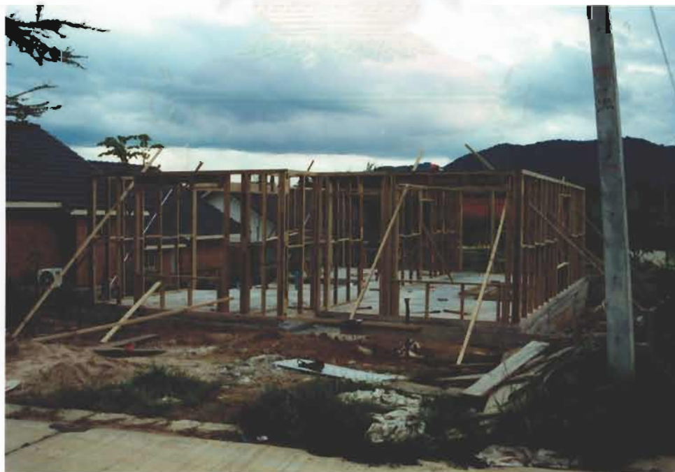
รูปที่ 4-26 การติดตั้งโครงผนังไม้ ทั้งหมด
