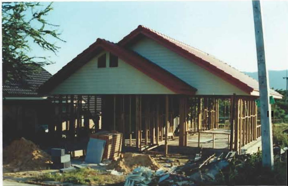
รูปที่ 4-39 ติดไม้ปิดหน้าจั่วทั้งสองด้านของอาคาร
