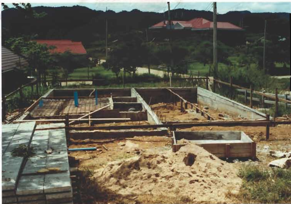
รูปที่ 4-17 ผนังฐานรากที่เสร็จแล้วทำการปรับระดับหลังกำแพงรอรังพื้นสำเร็จ
