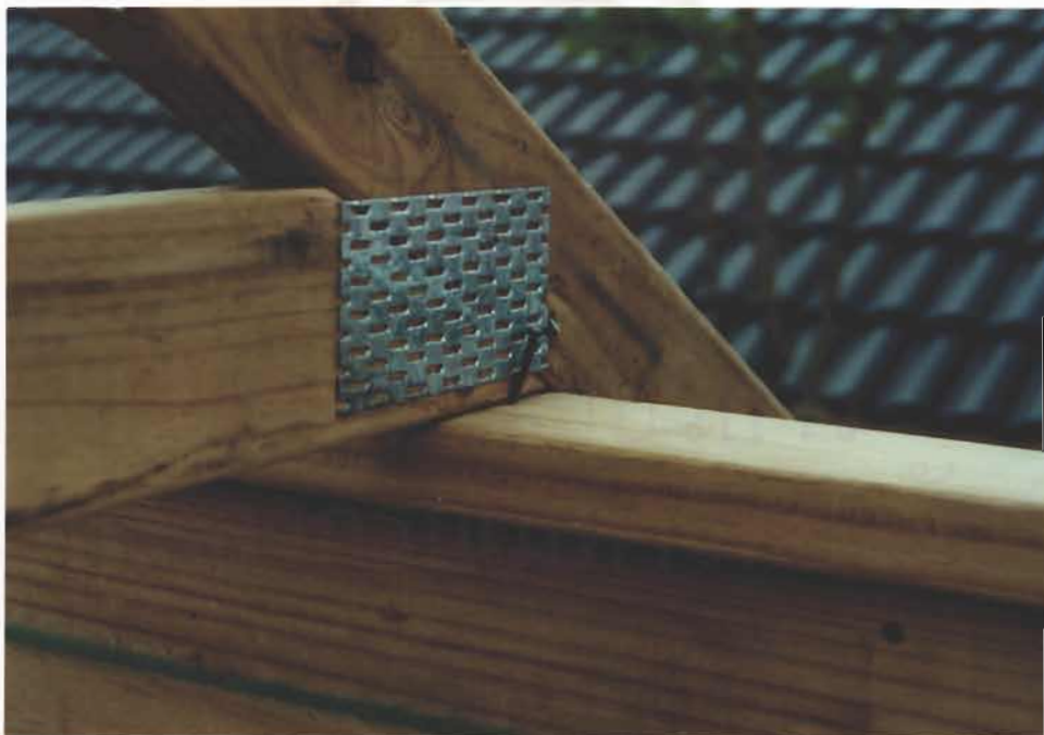
รูปที่ 4-32 การยึดโครงหลังคากับโครงผนังชั่วคราวด้วยตะปูขนาด 2 นิ้วเมื่อตรวจสอบระดับเรียบร้อยแล้วจึงจะทำการยึดด้วยตัวยึดถาวร (Multi Grip)
