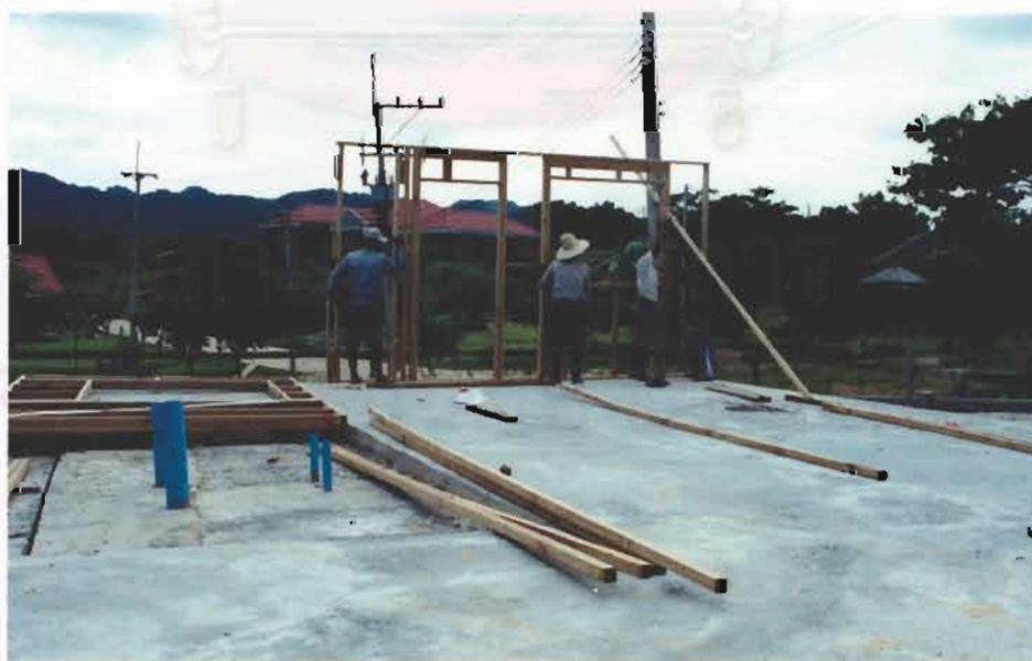
รูปที่ 4-24 การติดตั้งโครงผนังไม้
