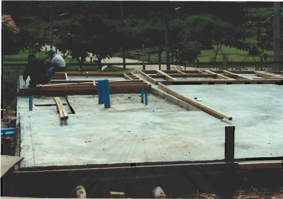
รูปที่ 4-20 การตีเส้นแนวโครงผนังไม้
