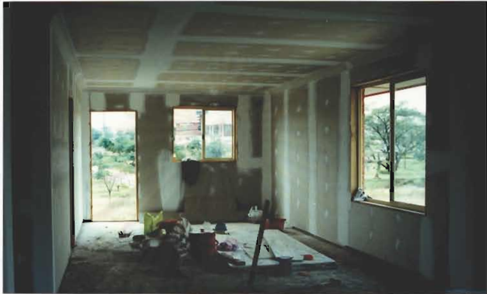
รูปที่ 4-52 การติดตั้งวัสดุกรุผนังภายในและฝ้าเพดานภายใน
