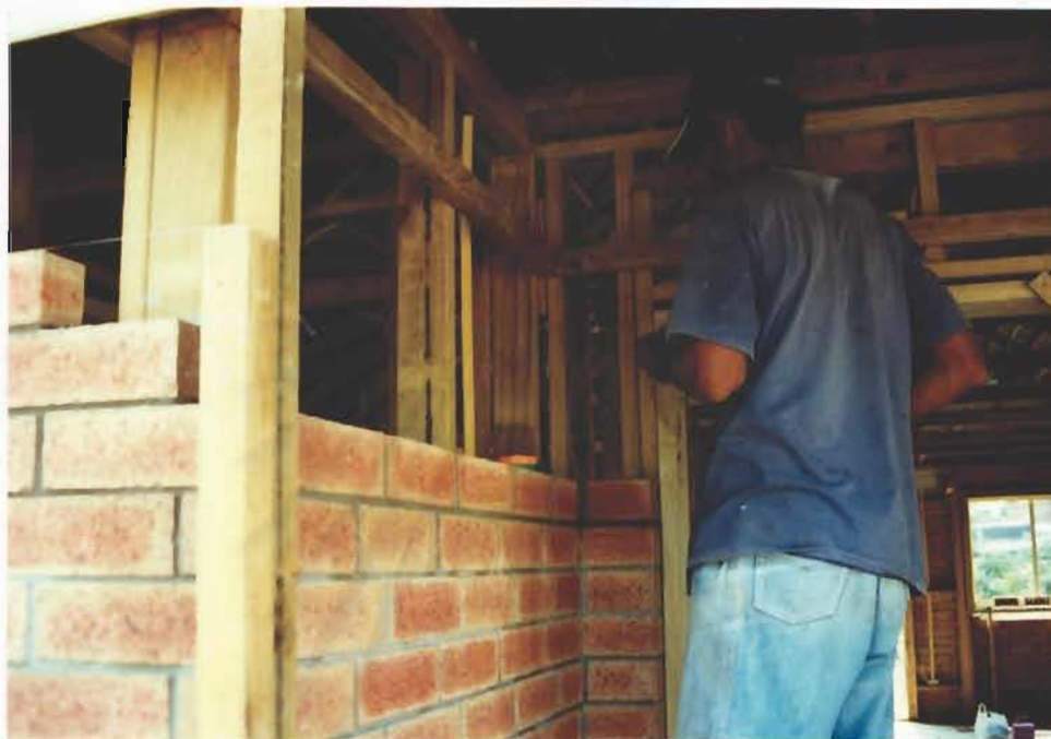
รูปที่ 4-47 การขึงเส้นเอ็นทั้งสองแนว
