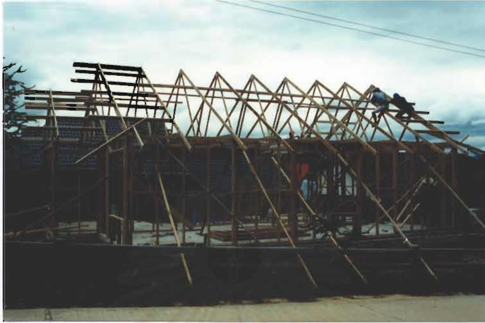
รูปที่ 4-35 โครงหลังคาที่ติดตั้งเรียบร้อยแล้ว
