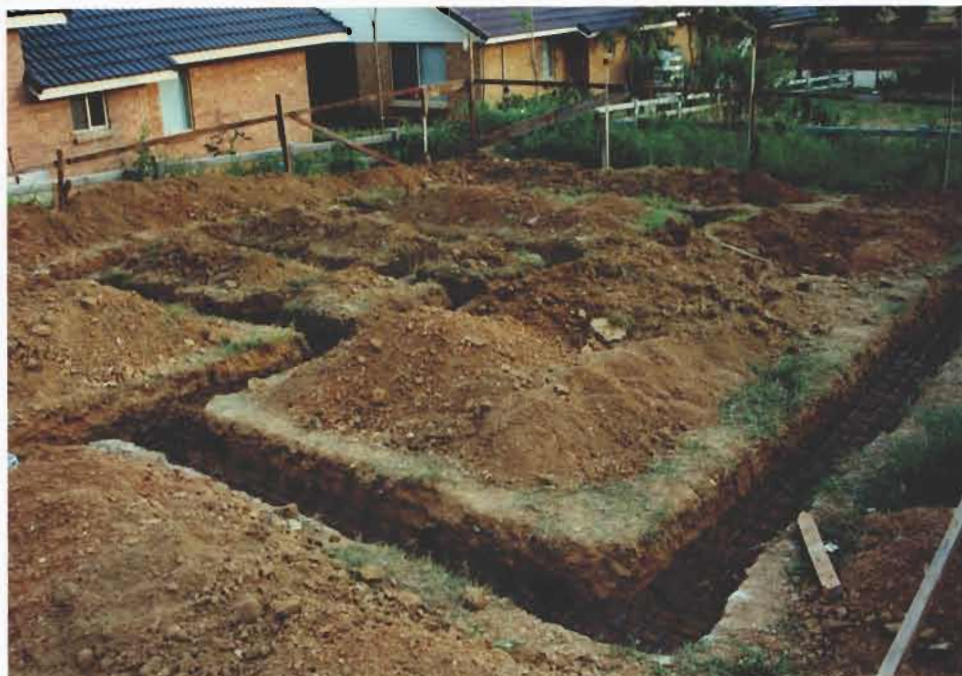
รูปที่ 4-13 การขุดดินทำฐานราก
