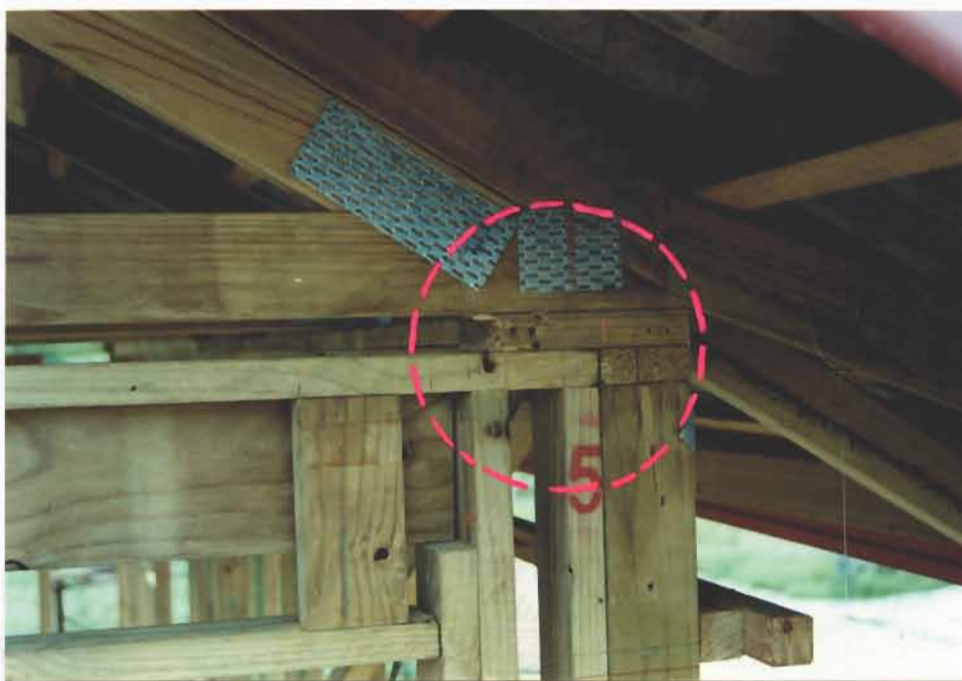
รูปที่ 4-73 การตัดไม้ทับหลังโครงผนังออกเนื่องจากบริเวณดังกล่าวไม่จำเป็นต้องทำการติดตั้ง
