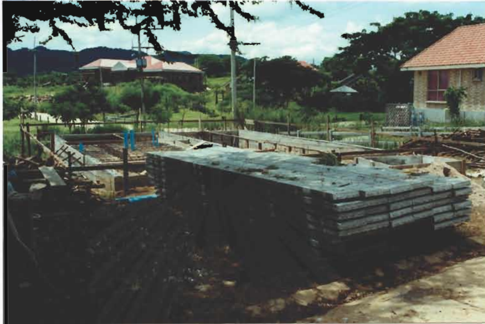
รูปที่ 4-18 พื้นสำเร็จรูปที่ใช้ในโครงการ
