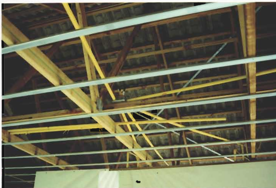
รูปที่ 4-45 โครงโครงฝ้าเพดานภายในจะยึดติดกับใต้ห้องโครงหลังคา
