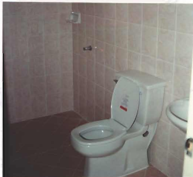
รูปที่ 4-55 การติดตั้งสุขภัณฑ์ภายในห้องน้ำ
