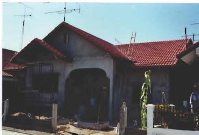
รูปที่ 4-64 การมุงกระเบื้องหลังคาอาคารระบบก่อสร้างทั่วไป วัสดุมุงหลังคาใช้กระเบื้องคอนกรีต (โมเนียตราเพชร)
