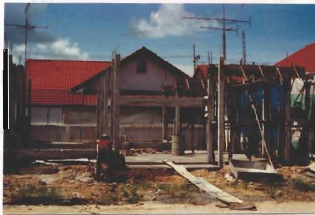
รูปที่ 4-61 เสาและคานหลังคาคอนกรีตเสริมเหล็ก งานเสาและคานทับโครงหลังคาเป็นโครงสร้างคอนกรีตเสริมเหล็กหล่อในที่
