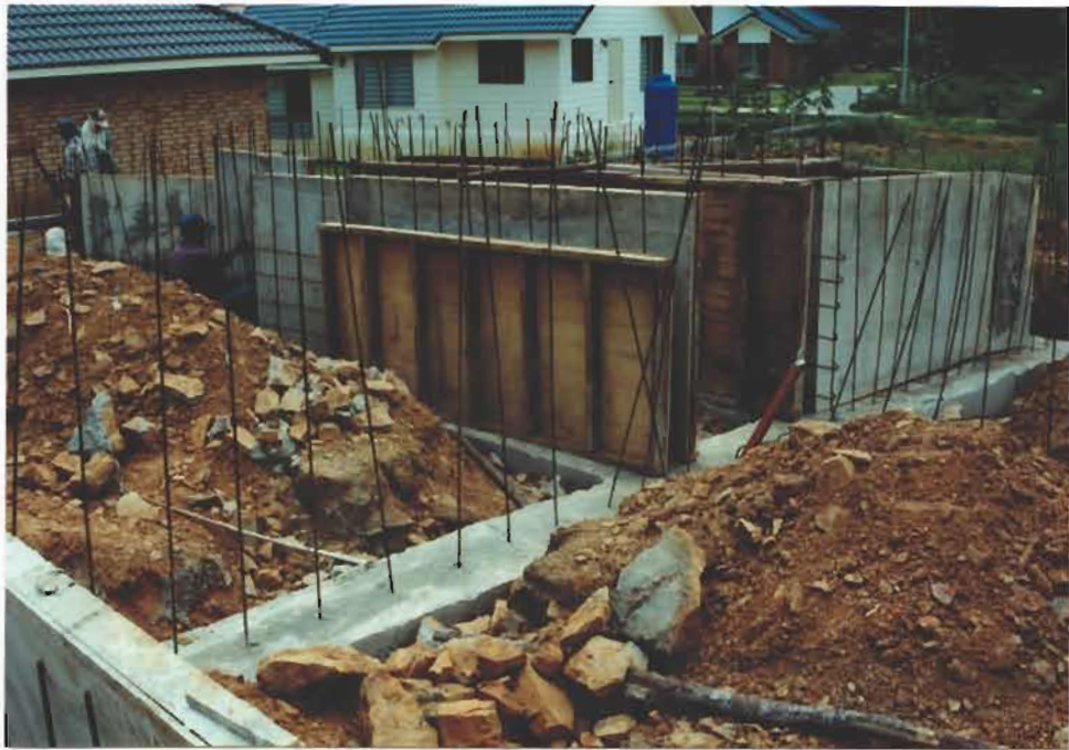
รูปที่ 4-16 วิธีการทำผนังฐานรากโดยใช้ไม้แบบเต็มแผ่น
