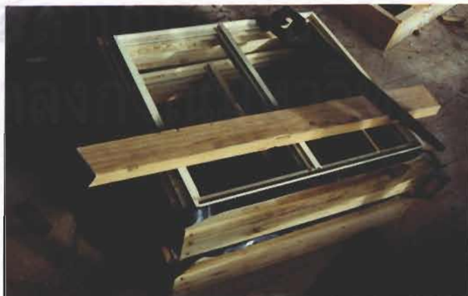
รูปที่ 4-42 ลักษณะของวงกบสำเร็จรูปที่ยึดกับแผ่นไม้แล้วรอการติดตั้ง
