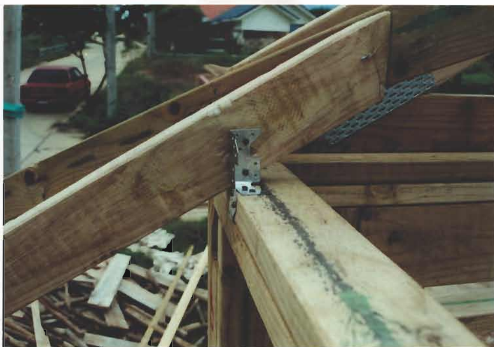
รูปที่ 4-34 หลังจากติดตั้งโครงไม้ได้ระดับแล้วยึดโครงผนังกับโครงหลังคาด้วยตัวยึด(Multi Grip)
