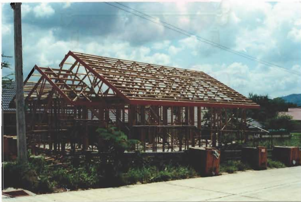
รูปที่ 4-38 การติดเชิงชายและแป้หลังคา
