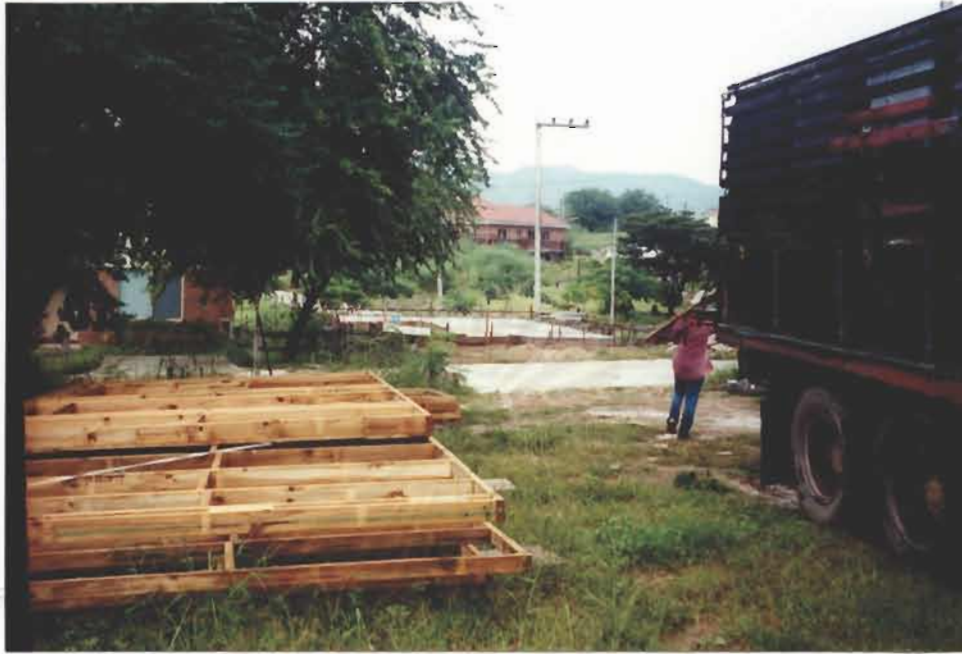
รูปที่ 4-21 การขนส่งโครงไม้สำเร็จรูปจากโรงงาน
