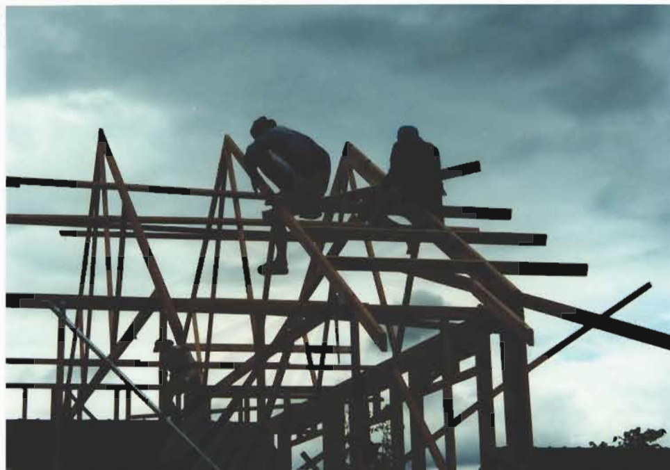
รูปที่ 4-33 การติดตั้งไม้จันทน์หน้าจั่ว
