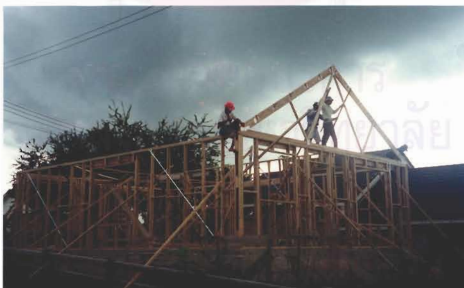
รูปที่ 4-30 การติดตั้งโครงหลังคาตัวแรกเริ่มจากด้านในสุด
