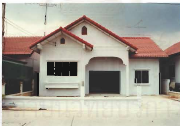
รูปที่ 4-65 การติดตั้งฝ้าชายคาภายนอกอาคาร งานฝ้าเพดานภายในแผ่นยิปซัมบอร์ดขนาด 60x60 เซนติเมตรโครงเคร่าที่บาร์ งานฝ้าเพดานภายนอกกระเบื้องซีเมนต์แผ่นเรียบโครงเคร่าไม้เนื้อแข็ง งานระบบไฟฟ้าเป็นสายไฟร้อยท่อฝังในผนัง งานระบบสุขาภิบาลใช้ถังเอร์อะถังซีเมนต์แบบทั่วไป
