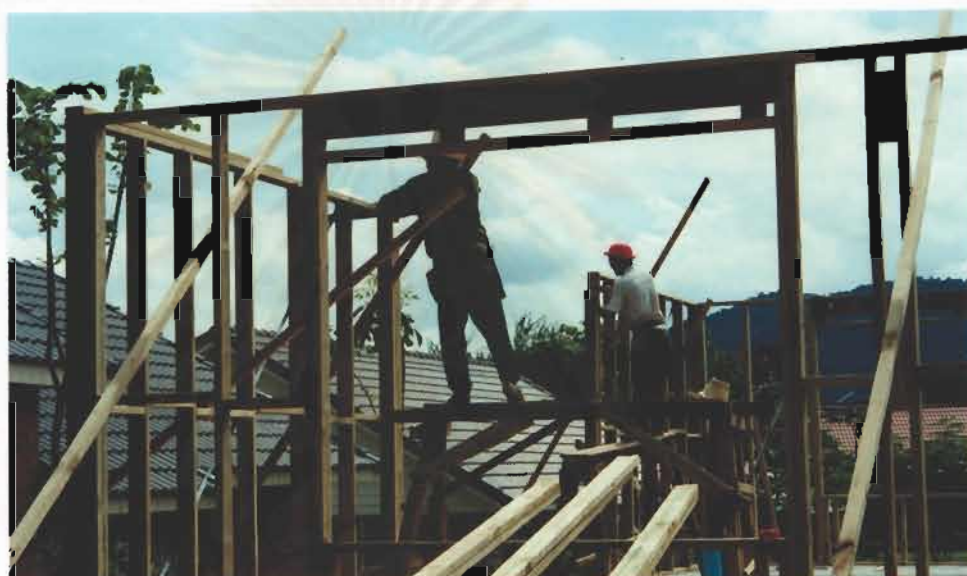
รูปที่ 4-71 การตัดโครงผนังเพื่อปรับระดับในการติดตั้งไม้คาน (Header)
