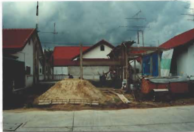
รูปที่ 4-60 การเทพื้นอาคารพักอาศัยระบบก่อสร้างทั่วไป งานพื้นอาคารแบ่งออกเป็น 3 ส่วน
