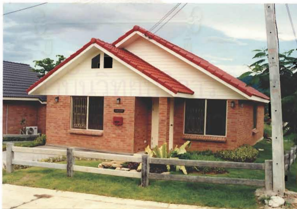
รูปที่ 4-5 ทัดนียภาพอาคารพักอาศัยแบบโครงสร้างไม้ 2 x 4 นิ้ว
