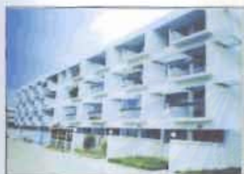
ภาพหน้าอาคารท.02- 3ชั้นนายพัน สูง 4 ชั้น
