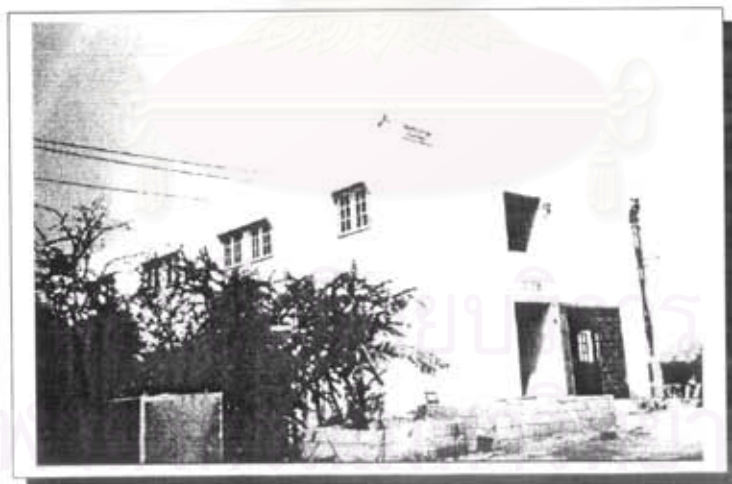
ภาพที่ 8 แสดงแพลตฟอร์มพัก ให้เช่าบริเวณแขวงแสมดำฝั่งตะวันตก
