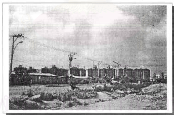
ภาพที่ 4 แสดงโครงการเคหะแห่งชาติ กำลังก่อสร้าง บริเวณริมถนนธนบุรี-ปากท่อ
