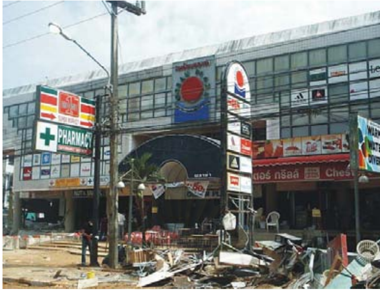
ภาพที่ 4.15 ภาพความเสียหายด้านหน้าของอาคารที่มีชั้นใต้ดิน
