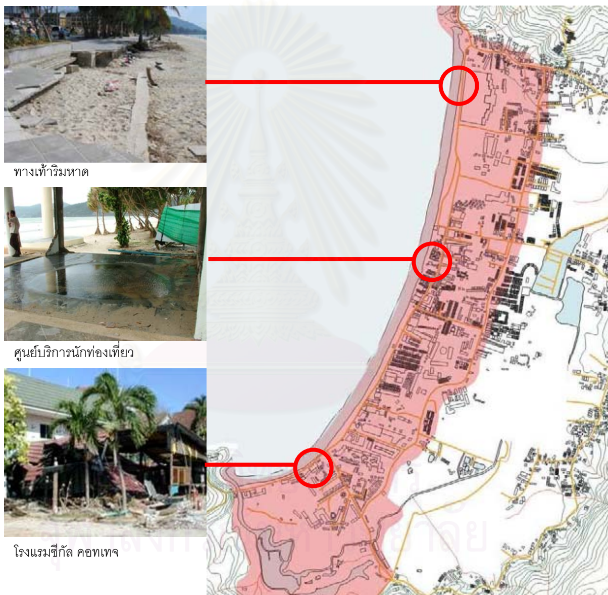
ภาพที่ 4.10 ตำแหน่งและความเสียหายของอาคารซึ่งตั้งอยู่ติดชายหาดป่าตอง
