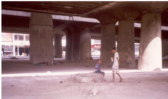
ภาพที่ 15. สภาพพื้นที่ใต้สะพานข้ามแยกรังสิต-ปทุมธานี
