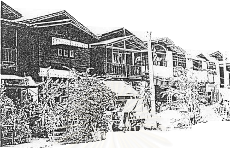
ภาพที่ 11 สภาพความหนาแน่นของการปลูกบ้านพักอาศัย โดยเว้นระยะห่าง จากแนวเขตที่ดินข้างละ 1.00 เมตร
