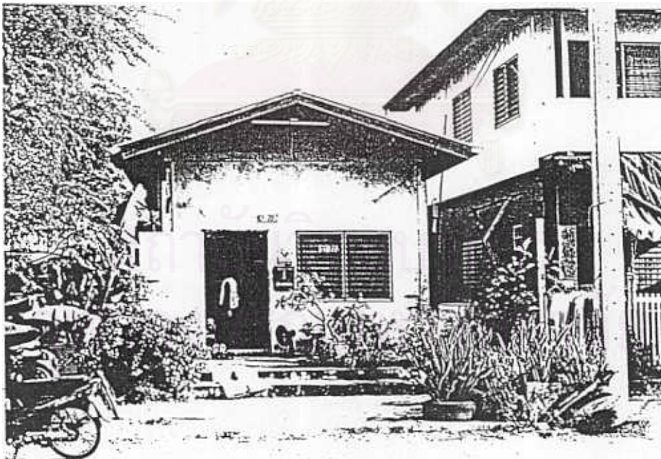
ภาพที่ 8 ลักษณะบ้านเดี่ยว 1 ชั้น ปลูกสร้างแบบถาวร เพื่อใช้เป็นที่อยู่อาศัยอย่างเดียว
