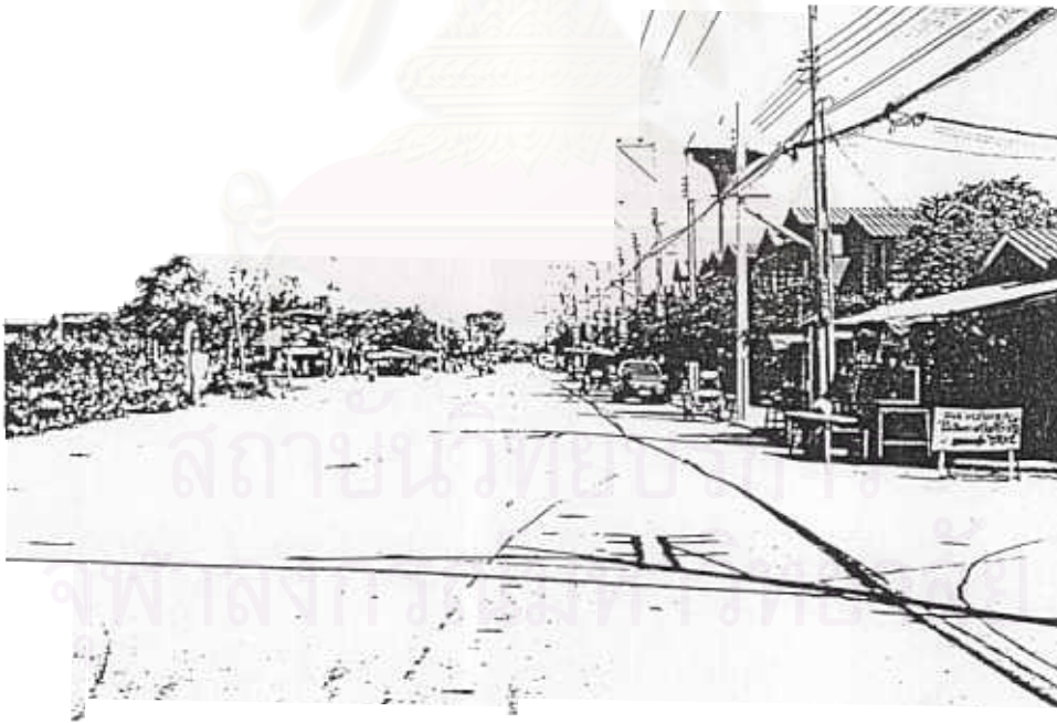
ภาพที่ 2 ถนนสายหลักในโครงการ เขตทางกว้าง 19.00 เมตร ผิวจราจรกว้าง 13.00 เมตร ทางเท้าสองข้างกว้างข้างละ 3.00 เมตร
