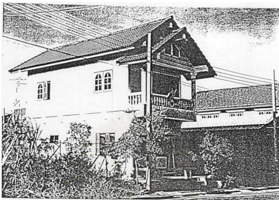
ภาพที่ 5 ลักษณะบ้านเดี่ยว 2 ชั้น ปลูกสร้างแบบถาวร เพื่อใช้เป็นที่อยู่อาศัยอย่างเดียว
