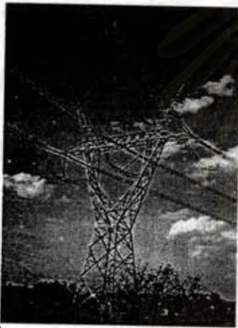
รูปที่ 3.21 สายส่ง 500 kV สายควบ วงจรเดี่ยว (MM3-TTK)
