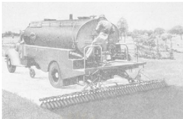
รูปที่ 2.11 แสดงการราดแอสฟัลต์ ลงบนถนนที่ไม่ได้ปูผิวทาง (Bruge, 1950)
