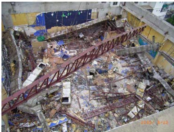
รูปที่ 3.43 การใช้เครนนำโครงหลังคาลงด้านล่างโดยไม่ต้องถอดส่วนหนึ่งส่วนใดของโครงหลังคาออก
