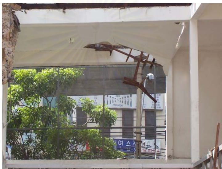
รูปที่ 3.52 ฝ้าเพดานที่ถูกรื้อโดยการทำให้หล่นลงด้านล่างทั้งหมดพร้อมกัน
