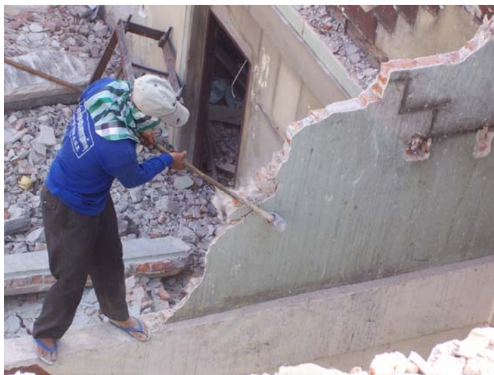
รูปที่ 3.35 คนงานกำลังสกัดผนังโดยเริ่มจากทางด้านบนลงด้านล่าง
