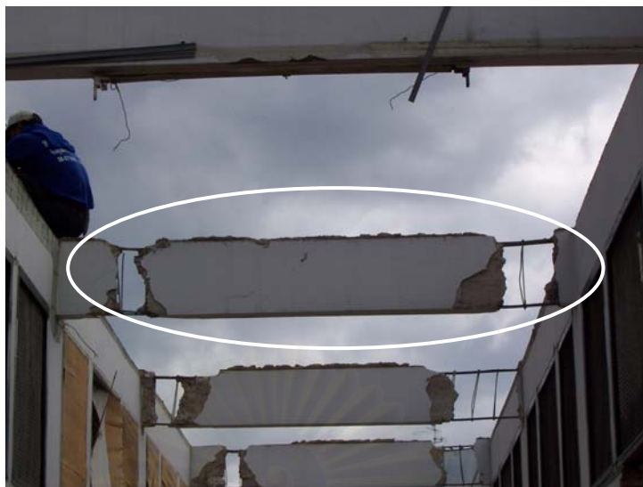
รูปที่ 3.21 คานคอนกรีตเสริมเหล็กที่สกัดปลายคานทั้งสองด้าน
