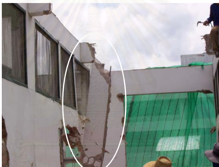
รูปที่ 3.22 คานคอนกรีตเสริมเหล็กที่ตัดเหล็กที่ปลายด้านหนึ่ง
