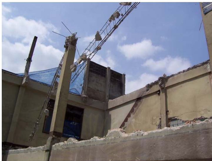
รูปที่ 3.3 การรื้อองค์อาคารส่วนที่ถ่ายน้ำหนักลงเสาก่อนทำการรื้อถอนเสา
