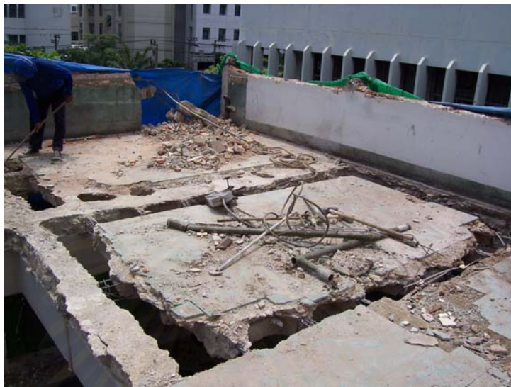
รูปที่ 3.17 พื้นคอนกรีตเสริมเหล็กที่ถูกสกัดคอนกรีตโดยรอบ
