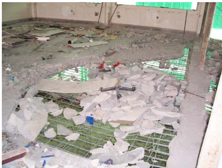
รูปที่ 3.14 การรื้อถอนพื้นคอนกรีตเสริมเหล็ก โดยเริ่มสกัดคอนกรีตที่มุมพื้น
