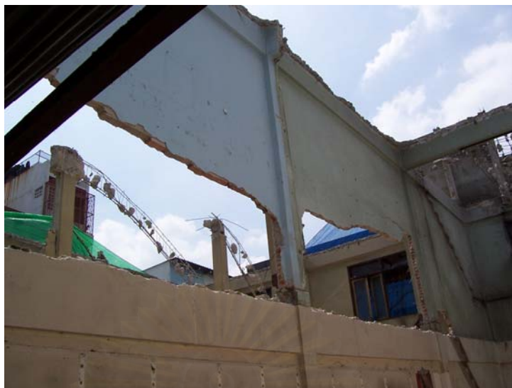
รูปที่ 3.31 การรื้อผนังภายในที่สกัดจากด้านล่างขึ้นไปยังด้านบน
