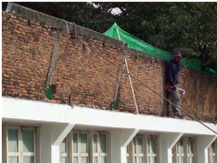
รูปที่ 3.62 การรื้อถอนผนังภายนอกโดยการล้มผนังเข้ามาในตัวอาคาร
