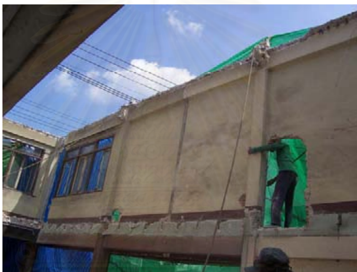
รูปที่ 3.57 การรื้อถอนผนังภายนอกโดยการสกัดเป็นช่องให้คนงานเข้าไปทำงาน
