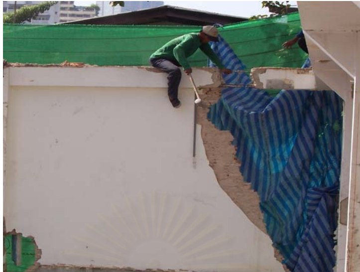
รูปที่ 3.61 การรื้อถอนผนังภายนอกโดยการตัดผนังออกเป็นชั้น
