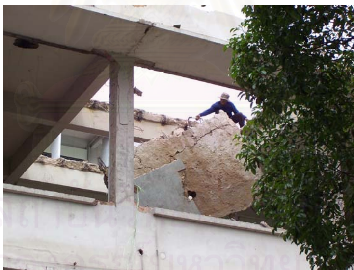
รูปที่ 3.18 คนงานกำลังตัดเหล็กเสริมพื้นที่สกัดคอนกรีตโดยรอบ
