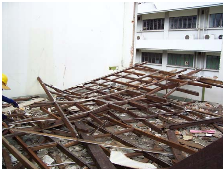
รูปที่ 3.54 โครงฝ้าเพดานที่ถูกรื้อลงมาจากหลังจากรื้อฝ้าลงมา
