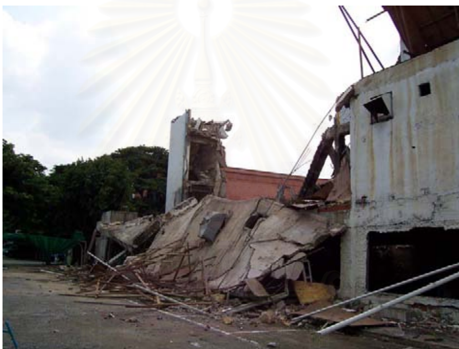
รูปที่ 3.64 โครงสร้างของอาคารที่พังทลายลงมาเนื่องจากโครงสร้างเดิมมีความบกพร่อง
