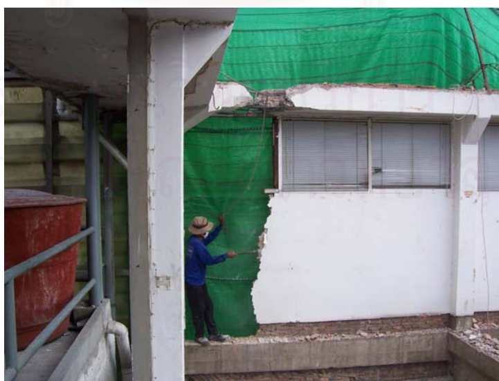
รูปที่ 3.58 การสกัดผนังภายนอกโดยการสกัดผนังให้เศษอิฐตกเข้ามาภายในอาคาร
