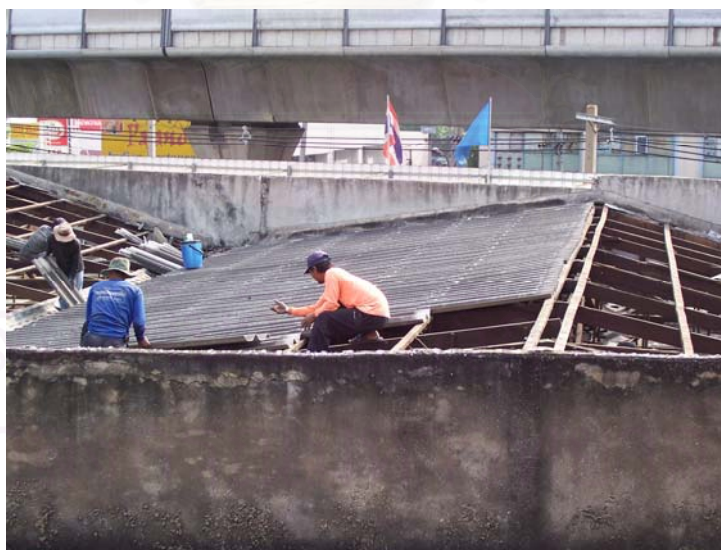
รูปที่ 3.47 การรื้อถอนวัสดุผนังหลังคา
