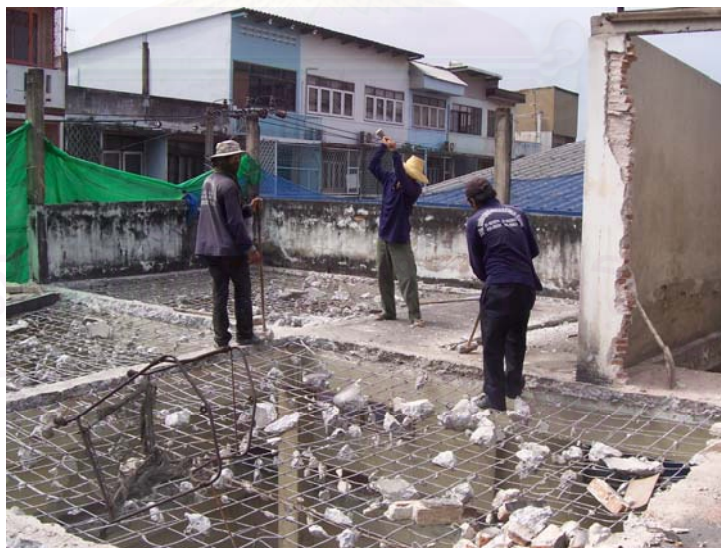
รูปที่ 3.15 การรื้อถอนพื้นคอนกรีตเสริมเหล็ก โดยทำการแบ่งพื้นออกเป็นสองส่วน
