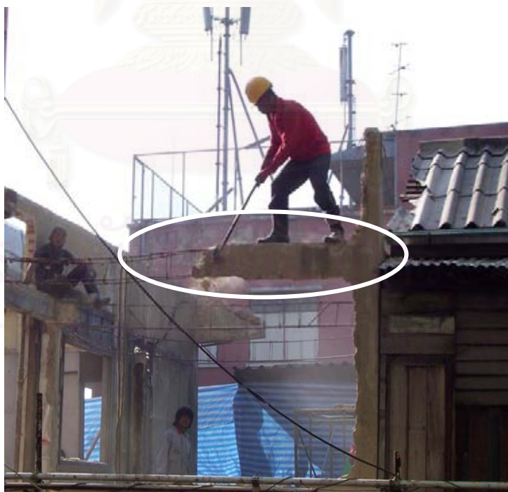
รูปที่ 3.25 การรื้อถอนโดยการสกัดแบบเดินถอยหลังจากปลายคานด้านหนึ่งจนกระทั่งไปสิ้นสุดที่ปลายคานอีกด้านหนึ่ง
