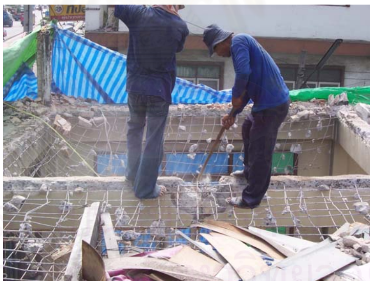
รูปที่ 3.28 การสกัดคานคอนกรีตเสริมเหล็กที่เริ่มจากบริเวณกลางคาน
