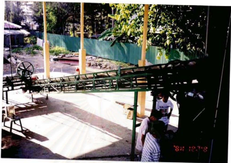
รูปที่ 7 สายพานระดับที่สอง
