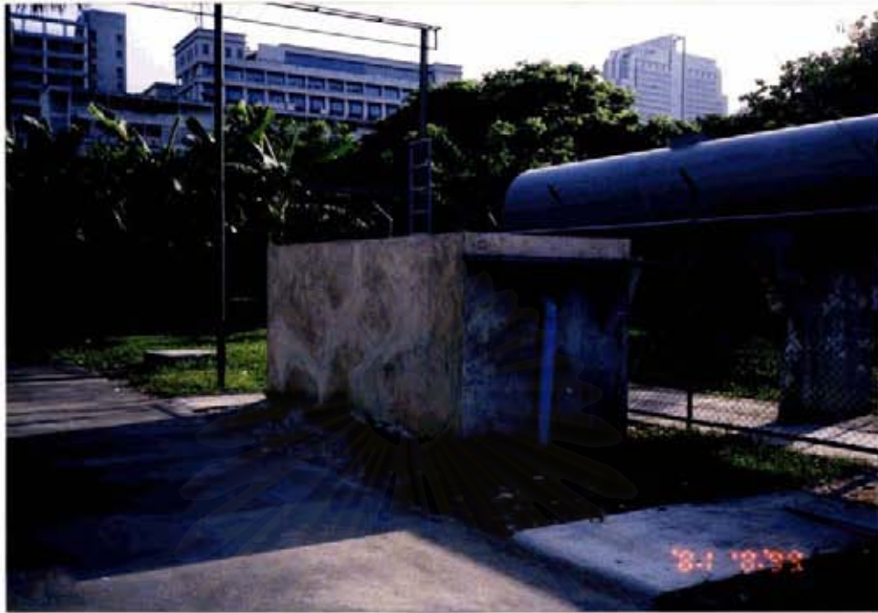
รูปที่ 16 บ่อบำบัดน้ำเสีย
