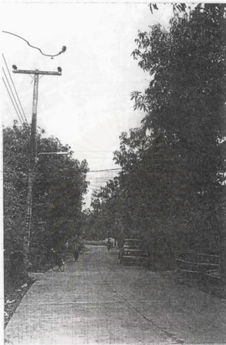
ภาพที่ 65 ถนนคอนกรีตภายในหมู่บ้านสำโรงโคเค่า
