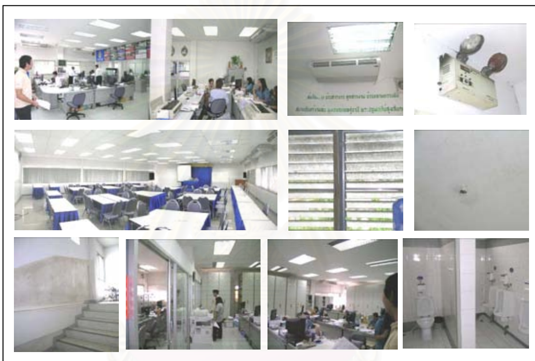
รูปภาพที่ 3.2 แสดงภาพภายในของอาคารสำนักงานภาค (นครปฐม)
