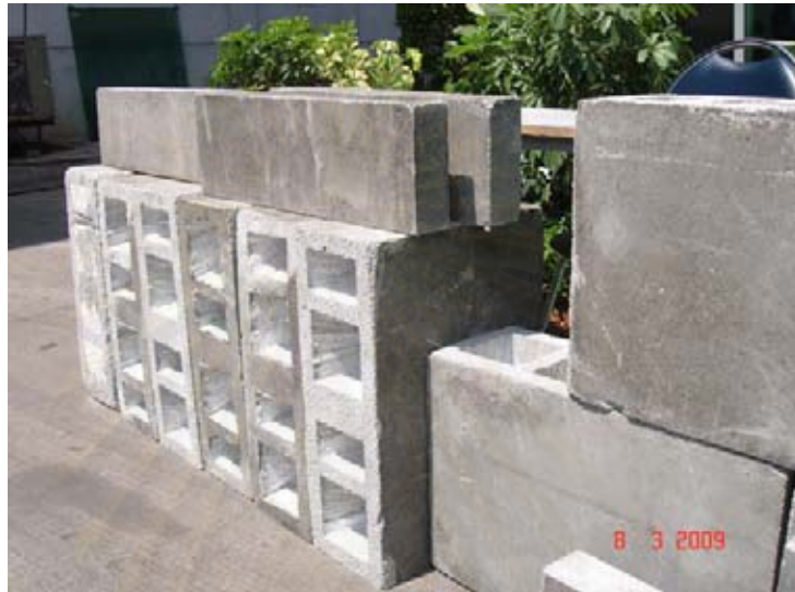
ภาพที่ 2.3 แสดงส่วนของโฟมคอนกรีตซึ่งใช้ในการสร้างบ้านผู้สูงอายุ
