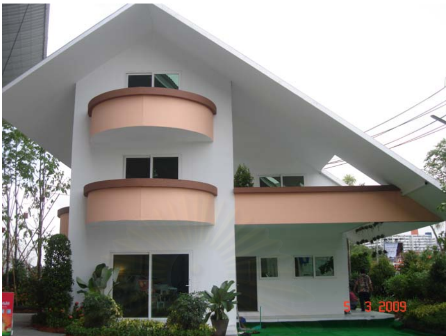
ภาพที่ 4.2 การก่อสร้างแบบไร้เสาของบ้านผู้โลกร้อน สามารถจอดรถได้ 2 คัน
