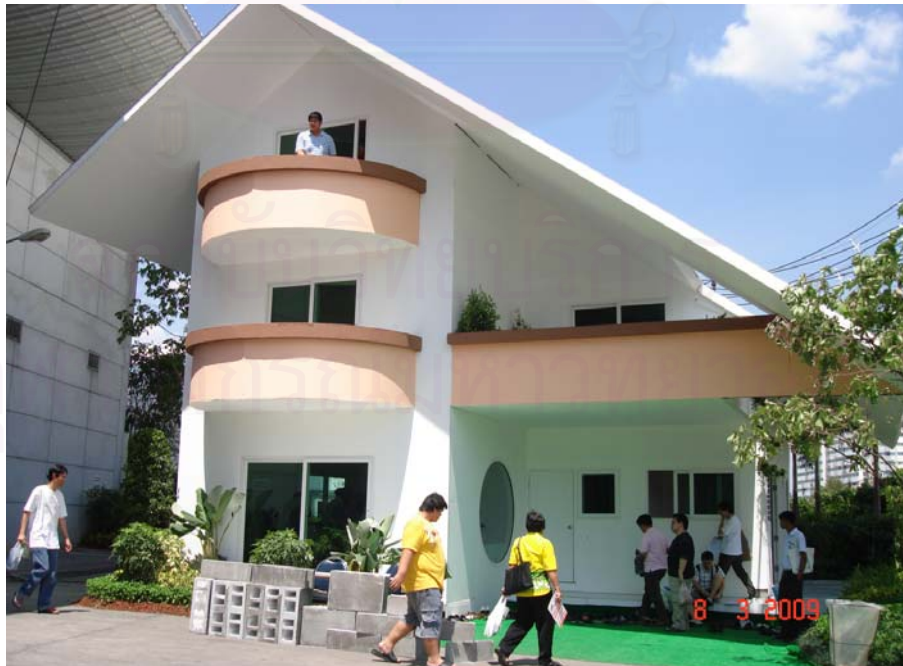
ภาพที่ 2.6 แสดงวัสดุหลังคาบ้านผู้ใจร้อน ที่สร้างขึ้นในงาน WAESE 2009
