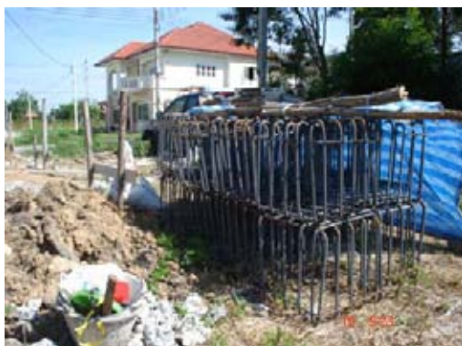
รูปที่ 4-39 เหล็กเสริมฐานรากที่เตรียมไว้ใช้งาน
