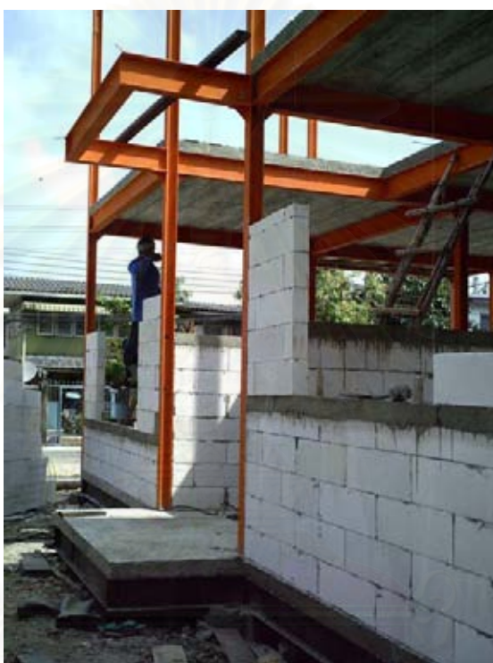
รูปที่ 4-88 ผนังก่อด้วยอิฐมวลเบาหนา 7" ทั้งภายนอกและภายใน
