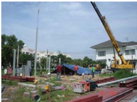
รูปที่ 4-54 การใช้ Mobile Crane ยกเสาเหล็กรูปพรรณ รูปที่ 4-55 การใช้เหล็กค้ำยันโครงสร้าง
