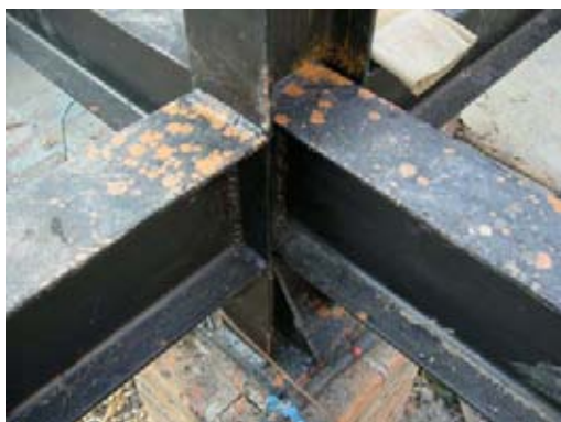
รูปที่ 4-86 รอยต่อโครงสร้างเสาคาน
