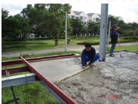
รูปที่ 4-64 คนงานกำลังปรับหน้าคอนกรีต
