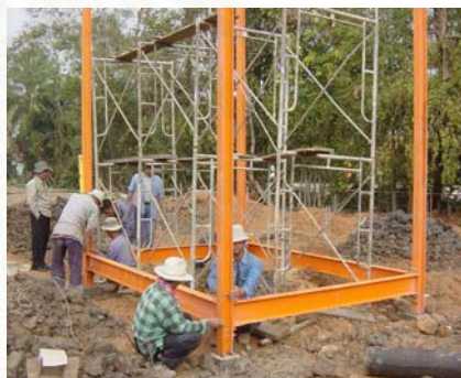
รูปที่ 4-24 การติดตั้งคานระบบเสา และคานสำเร็จรูป
