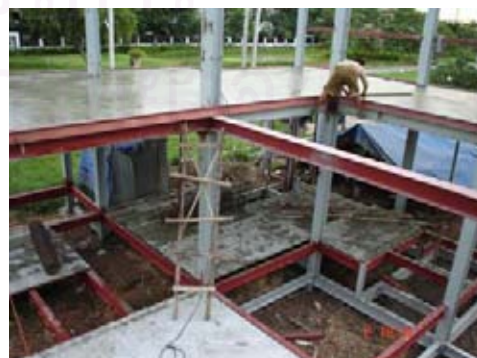
รูปที่ 4-65 คนงานกำลังขัดมันผิวคอนกรีต
