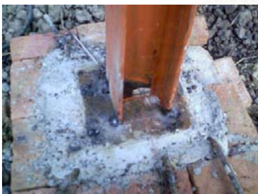
รูปที่ 4-81 การเชื่อมเสากับแผ่นประกับเหล็กตามตำแหน่งที่วัดระยะเอาไว้ล่วงหน้า
