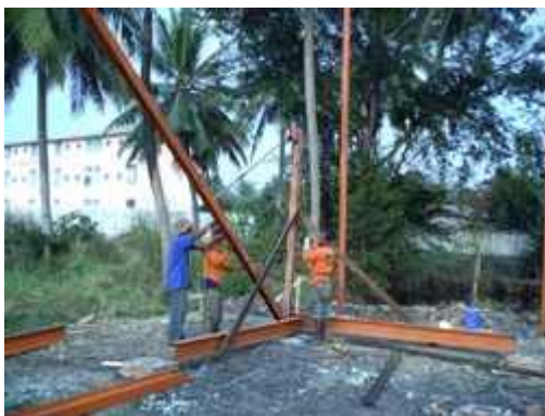
รูปที่ 4-80 วิธีการยกเสาขึ้นติดตั้งโดยการตั้งเสานขนาดเล็กและติดรอกโซ่
