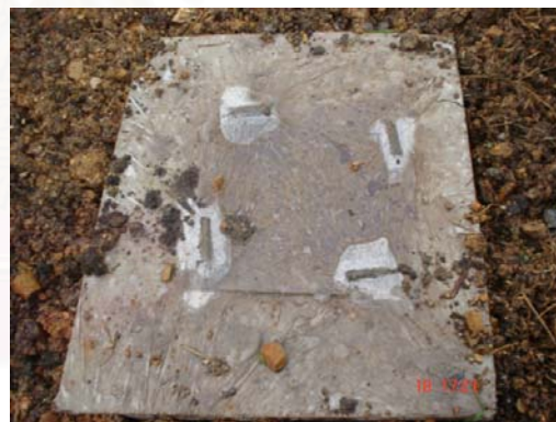
รูปที่ 4-50 ป่มคอนกรีตด้วยแผ่นพลาสติก
