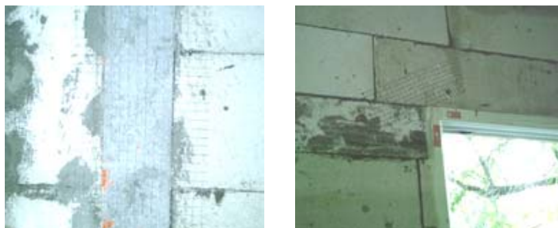
รูปที่ 6-3 การป้องกันการแตกร้าวโดยการเสริมลวดกรงไก่
