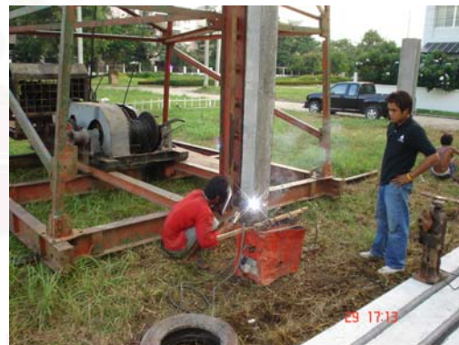
รูปที่ 4-38 แสดงการต่อเสาเข็มด้วยวิธีการเชื่อมไฟฟ้า
