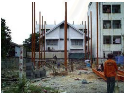
รูปที่ 4-82 เสาที่ติดตั้งบนฐานรากแล้วเสร็จ
