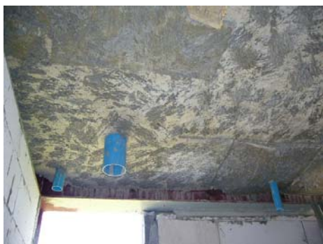
รูปที่ 4-66 การวางท่องานระบบสุขาภิบาลในพื้นที่
