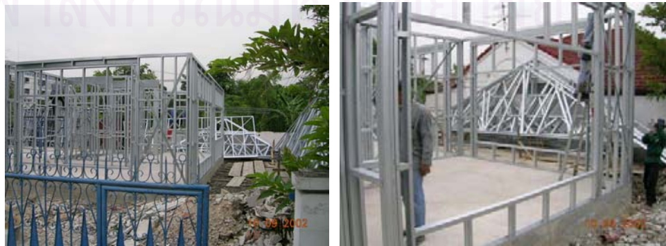
รูปที่ 4-123 การประกอบโครงสร้างบ้านระบบผนังรับน้ำหนัก
