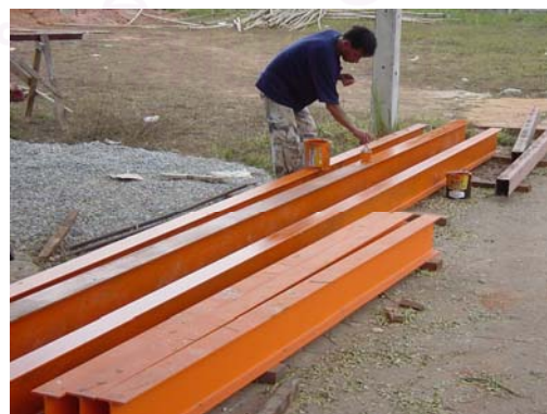
รูปที่ 4-12 แสดงการทำความสะอาดผิวเหล็กและการทาสีป้องกันสนิม
