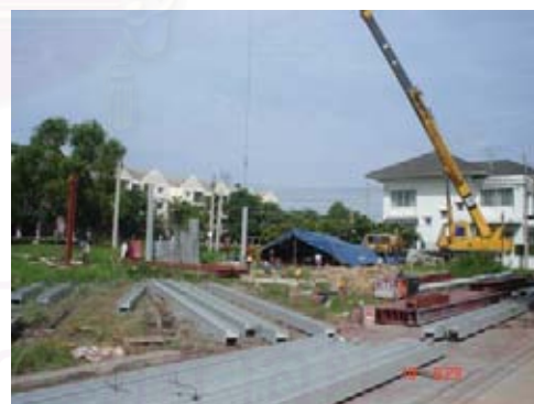
รูปที่ 4-36 แสดงการกองชิ้นส่วนโครงสร้าง (กองวัสดุบนถนนภายในโครงการ)
