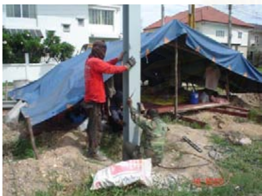
รูปที่ 4-56 เช็กระดับและตำแหน่งของเสา รวมถึงเช็คระยะและแนวตั้งของโครงสร้างโดยละเอียด
