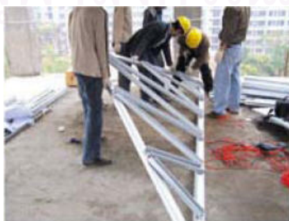
รูปที่ 4-113 การประกอบและติดตั้งชิ้นส่วนโครงสร้างหลังคาเหล็กมวลเบา
