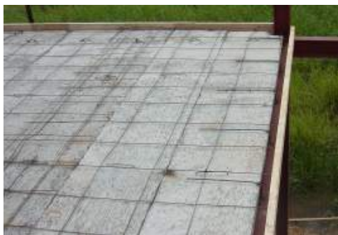
วางเหล็กเส้นตามแบบ กั้นไม้แบบและเทคอนกรีตทับหน้า
