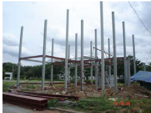
รูปที่ 4-59 คานเหล็กที่ติดตั้งระหว่างเสา
