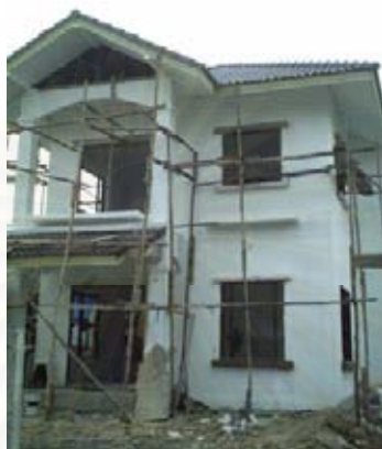
รูปที่ 4-89 การก่อสร้างส่วนตกแต่งต่างๆทำได้ไม่แตกต่างจากโครงสร้างบ้านคอนกรีต
