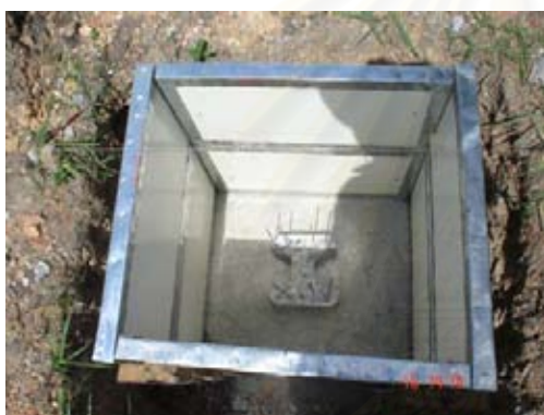
รูปที่ 4-41 แบบหล่อตอม่อ ค.ส.ล.
