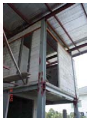
รูปที่ 4-67 ผนังก่ออิฐมวลเบาที่ใช้ในการก่อผนังทั้งผนังภายนอกและผนังภายในหลังคา (Roof)
