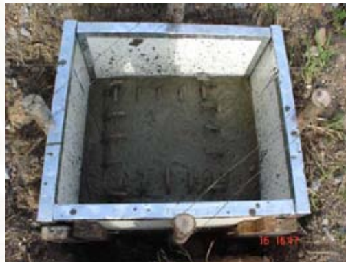
รูปที่ 4-42 เทคอนกรีตผสมเสร็จในแบบ
