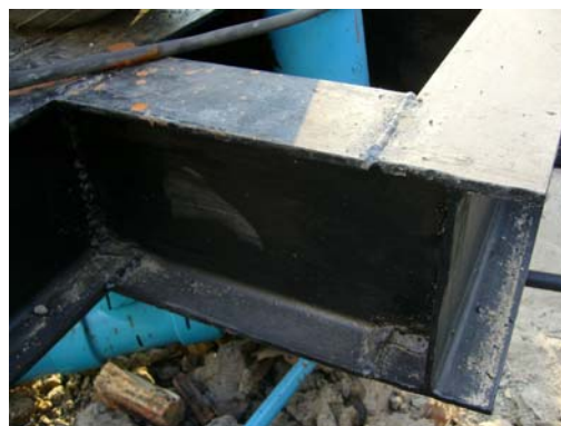
รูปที่ 4-87 ทำรอยต่อส่วนคานยื่น
