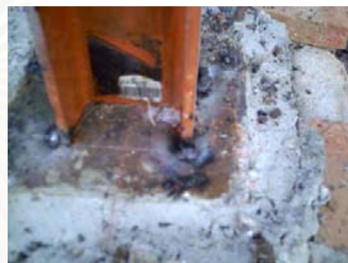
รูปที่ 4-81 การเชื่อมเสากับแผ่นประกับเหล็กตามตำแหน่งที่วัดระยะเอาไว้ล่วงหน้า
