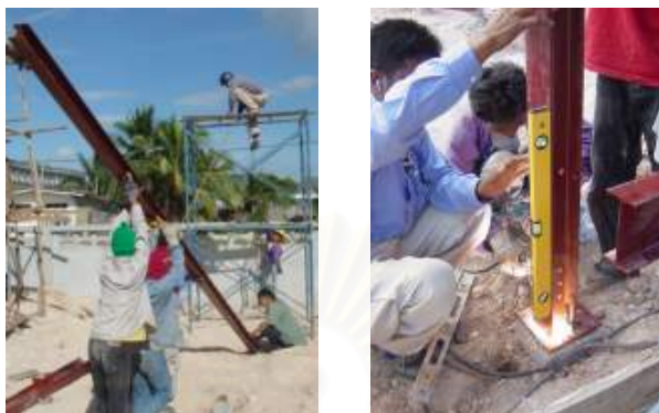
รูปที่ 4-21 การตั้งเสาโครงสร้างเหล็ก
