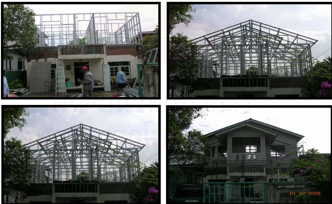
รูปที่ 6-5 งานต่อเติมบ้านพักอาศัยโดยใช้โครงคร่าวเหล็กชุบสังกะสี โดยข้อดีของโครงสร้างคือน้ำหนักเบา
