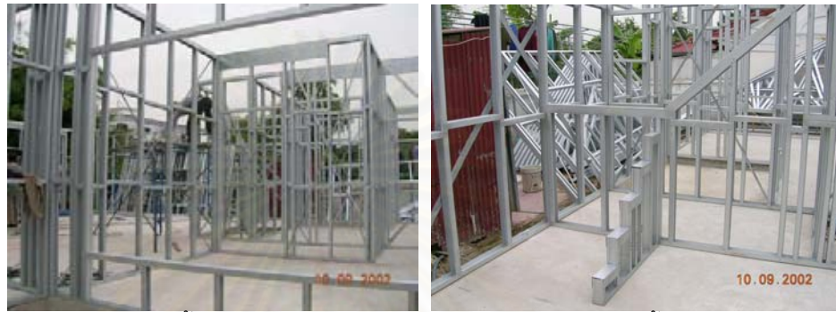
รูปที่ 4-124 ติดตั้งส่วนประกอบโครงสร้างโดยให้แล้วเสร็จที่ระดับ และรวมถึงงานโครงสร้างบันได
