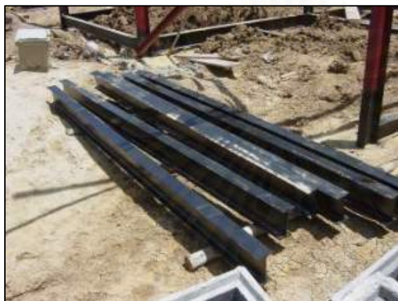
รูปที่ 4-13 ทาสี Coal Tar Epoxy เพื่อป้องกันความชื้นจากพื้นดิน
