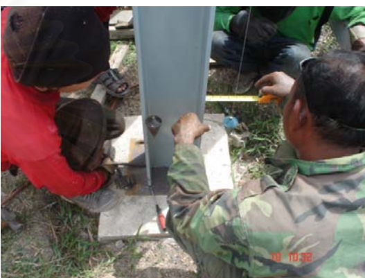
รูปที่ 4-56 เช็กระดับและตำแหน่งของเสา รวมถึงเช็คระยะและแนวตั้งของโครงสร้างโดยละเอียด
