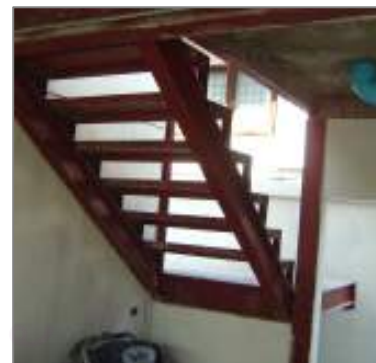
8. คานบันได
