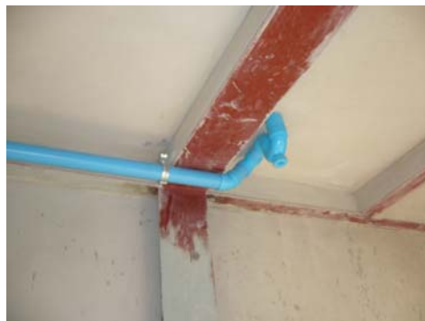
รูปที่ 4-66 การวางท่องานระบบสุขาภิบาลในพื้นที่
