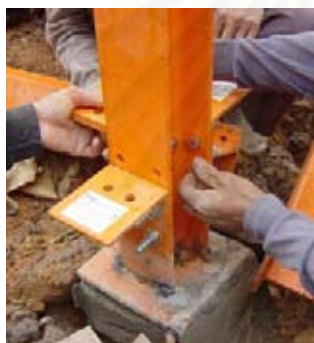
รูปที่ 4-24 การติดตั้งคานระบบเสา และคานสำเร็จรูป
