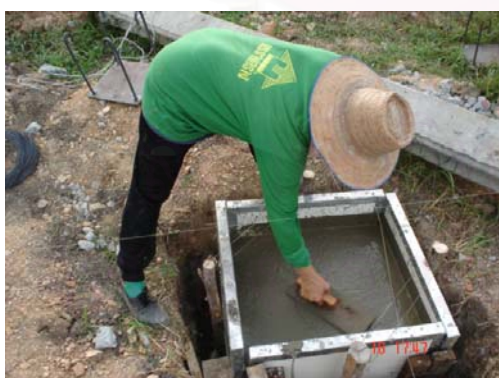
รูปที่ 4-43 ปรับหน้าคอนกรีตให้เรียบได้ระดับ
