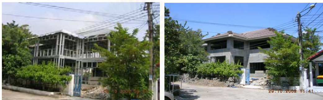
รูปที่ 4-128 บ้านก่อนและหลังการติดตั้งวัสดุแผ่นผนัง
