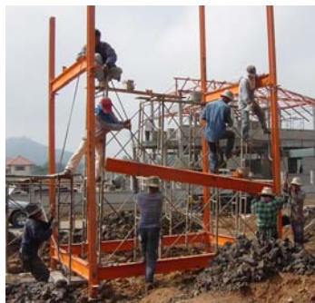
รูปที่ 4-23 การยกคานเพื่อติดตั้ง
