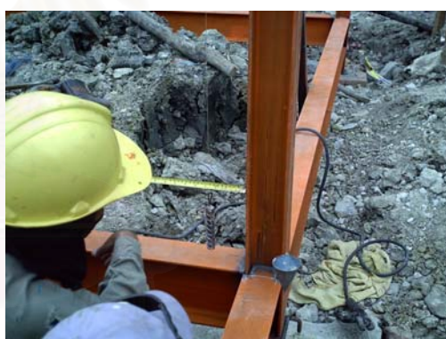
รูปที่ 4-83 หาแนวตั้งของโครงสร้างเสา
