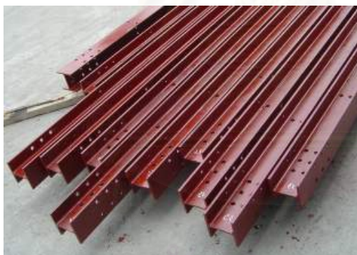
รูปที่ 4-11 การกองวัสดุเหล็กโครงสร้าง
