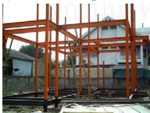
รูปที่ 4-84 การประกอบโครงสร้างเสาคาน
