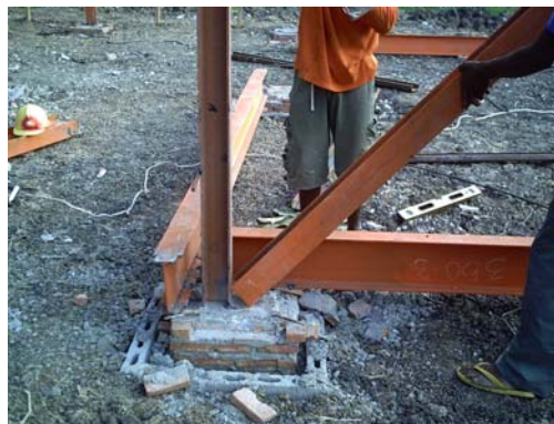
รูปที่ 4-80 วิธีการยกเสาขึ้นติดตั้งโดยการตั้งเสานขนาดเล็กและติดรอกโซ่
