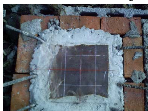
รูปที่ 4-79 การหล่อคอนกรีตฐานรากและฝังแผ่นประทับเหล็กในขณะที่คอนกรีตยังไม่แห้ง
