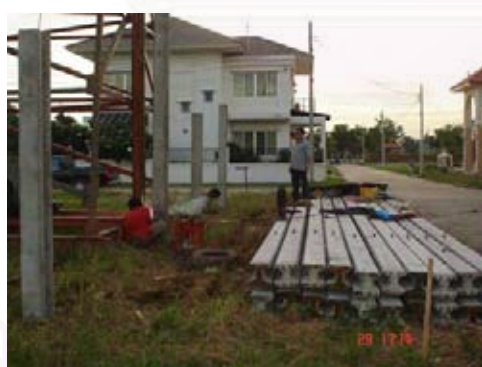
รูปที่ 4-36 แสดงการกองชิ้นส่วนโครงสร้าง (กองวัสดุบนถนนภายในโครงการ)
