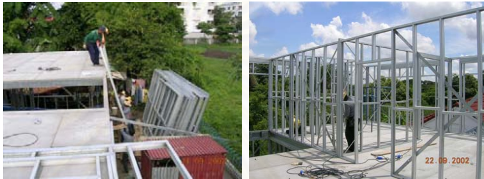
รูปที่ 4-126 การขนส่งแผงโครงสร้างและการติดตั้งโครงสร้างผนังรับน้ำหนักชั้นที่ 2
