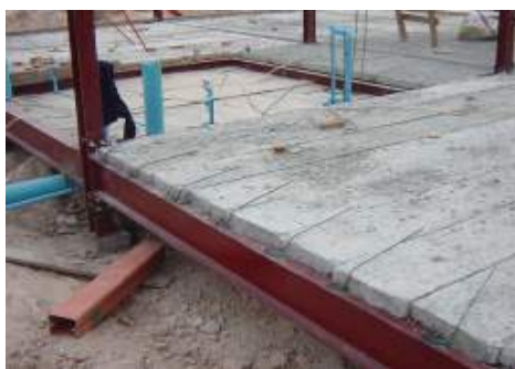
เชื่อมเหล็กเส้น (Shear Stud) กับหลังคาน
