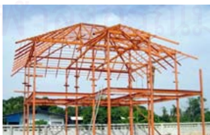
รูปที่ 4-7 โครงหลังคาเหล็กที่เห็นกันโดยทั่วไป
