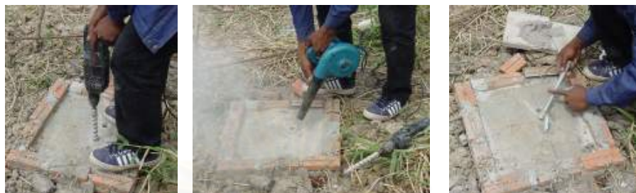
รูปที่ 4-18 ขั้นตอนการเจาะรูและเตรียมการสำหรับยึดโครงสร้างเสา
