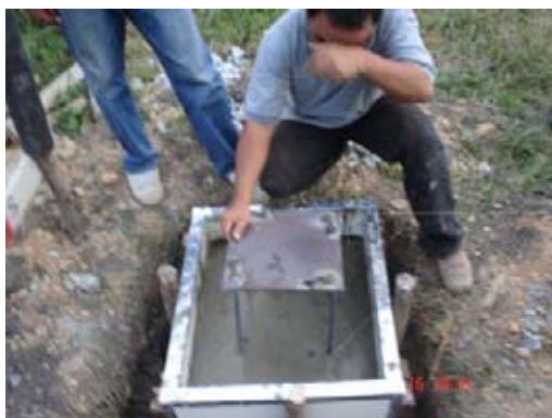
รูปที่ 4-45 การวางแผ่นประกบเหล็ก
