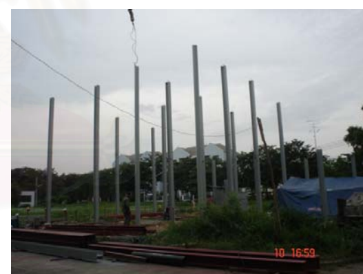
รูปที่ 4-57 แสดงการเชื่อมไฟฟ้ายึดฐานเสาเหล็กกับแผ่นประกับเหล็กฐานรากและเสาที่ติดตั้งเรียบร้อยแล้ว
