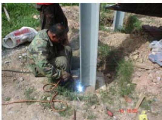
รูปที่ 4-57 แสดงการเชื่อมไฟฟ้ายึดฐานเสาเหล็กกับแผ่นประกับเหล็กฐานรากและเสาที่ติดตั้งเรียบร้อยแล้ว
