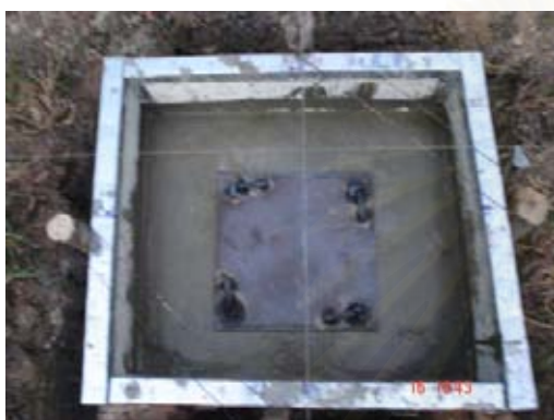
รูปที่ 4-47 สุสานรากที่เสร็จเรียบร้อยแล้ว
