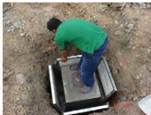
รูปที่ 4-48 การถอดแบบหล่อฐานราก
