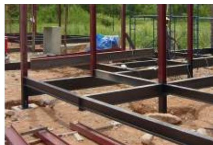
รูปที่ 4-26 คานเหล็กก่อนและหลังการเก็บสีกันสนิม
