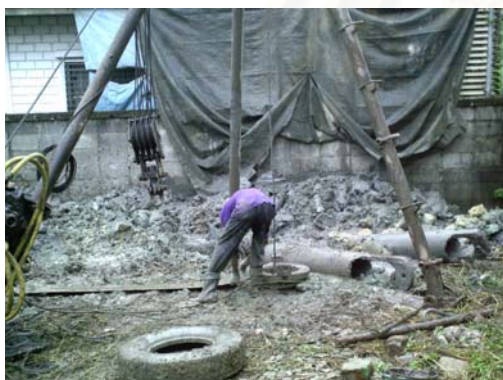
รูปที่ 4-77 ใช้ระบบเสาเข็มเจาะ
