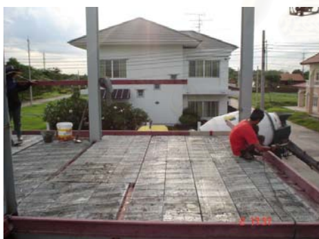
รูปที่ 4-62 วางเหล็กตะแกรงก่อนเทคอนกรีต
