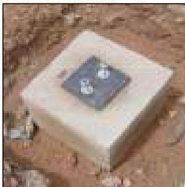
รูปที่ 4-16 ติดตั้งแบบใช้โบลท์ตัวเจ (J Bolt)
