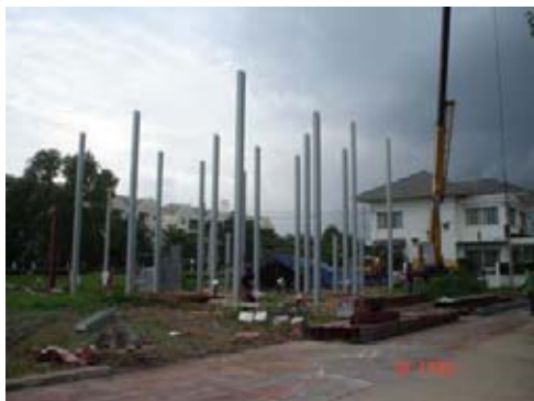
รูปที่ 4-58 การใช้ Mobile Crane ยกขึ้นส่วนคานเหล็ก
