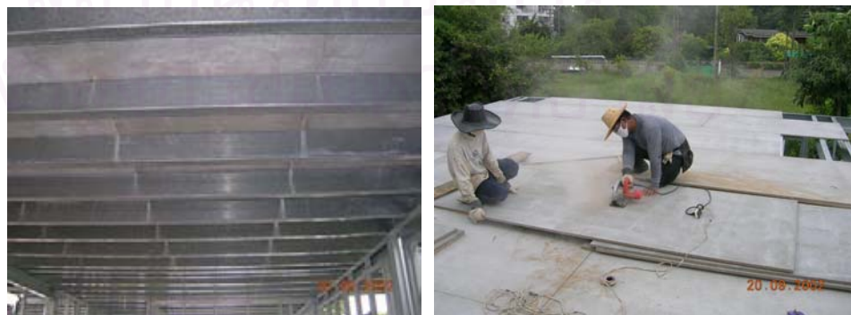
รูปที่ 4-125 งานโครงสร้างพื้น จะเป็นโครงสร้างโดยการวางตงและปูทับด้วยวัสดุแผ่นพื้น
