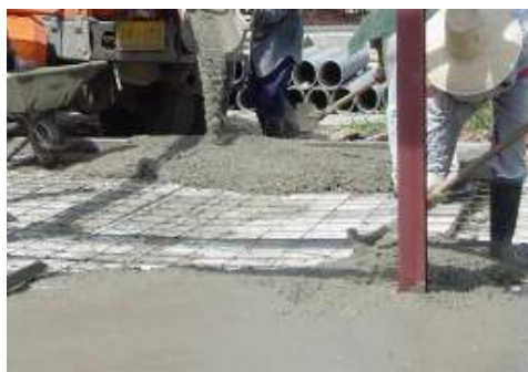
วางเหล็กเส้นตามแบบ กั้นไม้แบบและเทคอนกรีตทับหน้า
