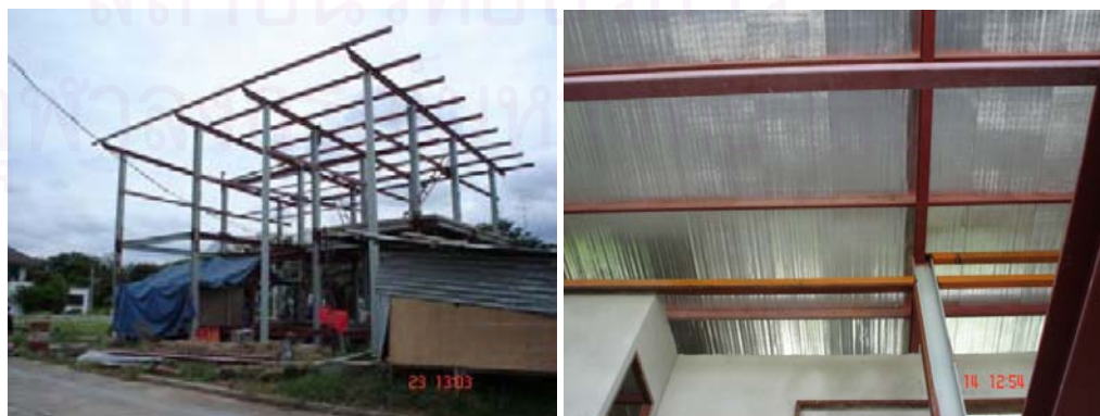
รูปที่ 4-69 โครงสร้างหลังคาเหล็ก และ วัสดุมุงแผ่นเหล็กที่รัดลอนมีการติดตั้งฉนวนกันความร้อน
