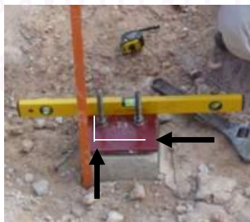
รูปที่ 4-20 การหาระดับและตำแหน่งเสาที่จะวางบนประกับเหล็ก
