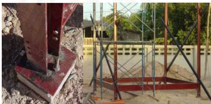
รูปที่ 4-22 การยึดเสากับแผ่นเหล็กประกบ
