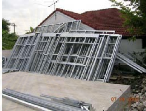
รูปที่ 4-122 ส่วนประกอบโครงสร้างบ้านระบบผนังรับน้ำหนัก และลักษณะการกรงวัสดุ
