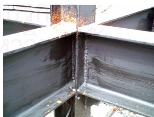
รูปที่ 4-85 ทำรอยต่อด้วยการเชื่อมไฟฟ้า
