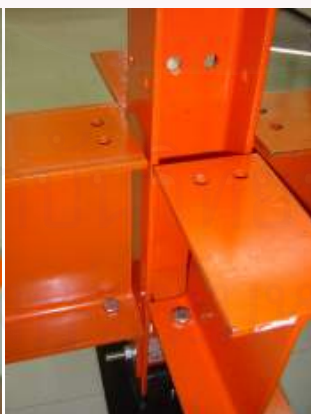
รูปที่ 4-24 การติดตั้งคานระบบเสา และคานสำเร็จรูป
