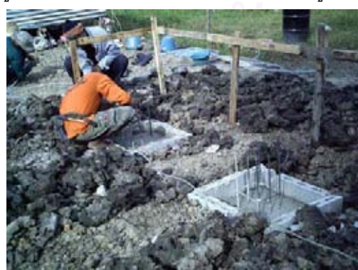
รูปที่ 4-79 การหล่อคอนกรีตฐานรากและฝังแผ่นประทับเหล็กในขณะที่คอนกรีตยังไม่แห้ง
