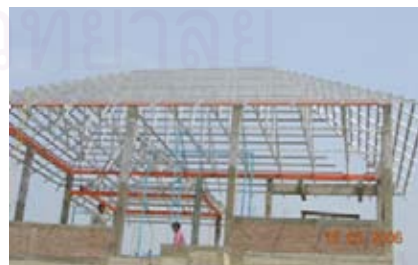
รูปที่ 4-8 โครงหลังคาเหล็ก กึ่งสำเร็จรูป
