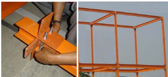
รูปที่ 4-28 การติดตั้งโครงหลังคาเหล็ก
