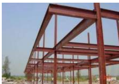
รูปที่ 4-26 คานเหล็กก่อนและหลังการเก็บสีกันสนิม
