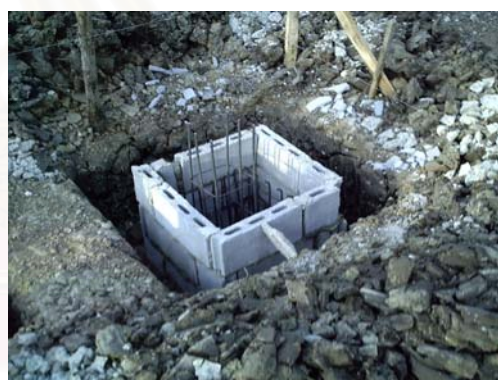
รูปที่ 4-78 การเตรียมแบบหล่อตอม่อโดยการก่ออิฐบล็อก
