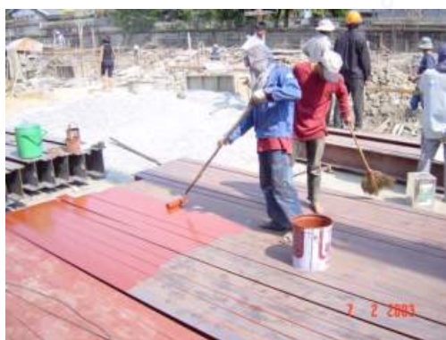
รูปที่ 4-12 แสดงการทำความสะอาดผิวเหล็กและการทาสีป้องกันสนิม
