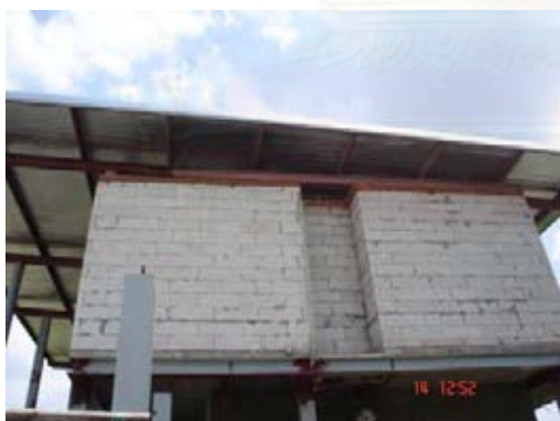
รูปที่ 4-67 ผนังก่ออิฐมวลเบาที่ใช้ในการก่อผนังทั้งผนังภายนอกและผนังภายในหลังคา (Roof)
