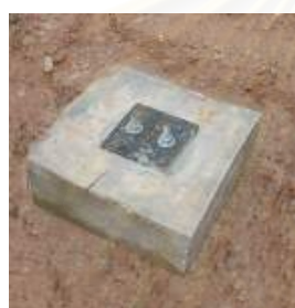
รูปที่ 4-18 ขั้นตอนการเจาะรูและเตรียมการสำหรับยึดโครงสร้างเสา
