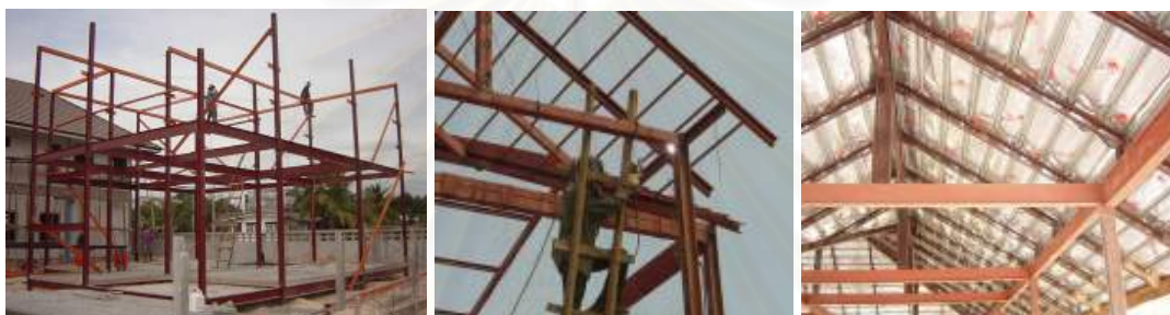
รูปที่ 4-29 หลังคาเหล็กระบบเชื่อม
