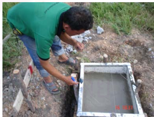
รูปที่ 4-44 การหาตำแหน่งวางแผ่นประทับกับเหล็ก
