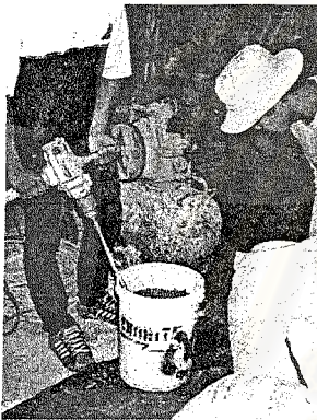
(ก) การผสมวัสดุกันไฟกับน้ำก่อนพ่น
