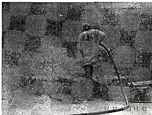
(ก) การขัดผิวเหล็กด้วยการพ่นทราย
